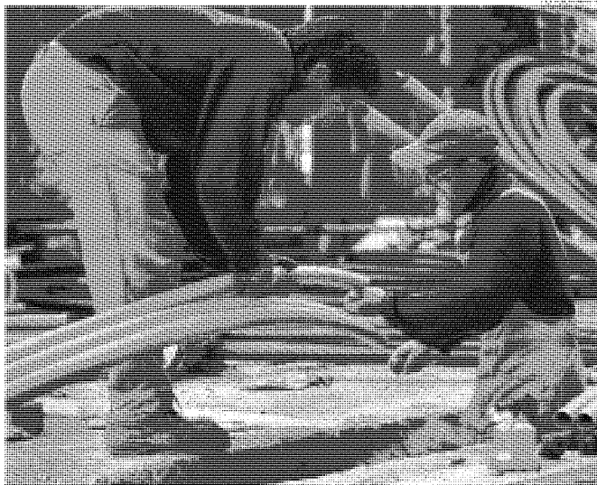
Banda larga. La posa dei cavi per le telecomunicazioni
