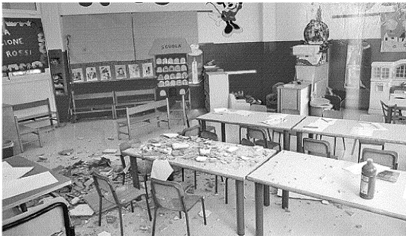
Calcinacci L'aula della scuola materna «Vittorino da Feltre» di Sesto San Giovanni: l'intonaco del soffitto è crollato su sette bambini (Photoviews)
