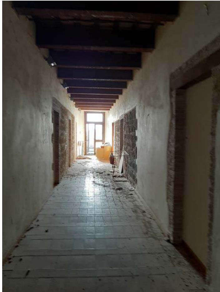
Foto 6 – Particolare interno del corridoio al piano secondo
