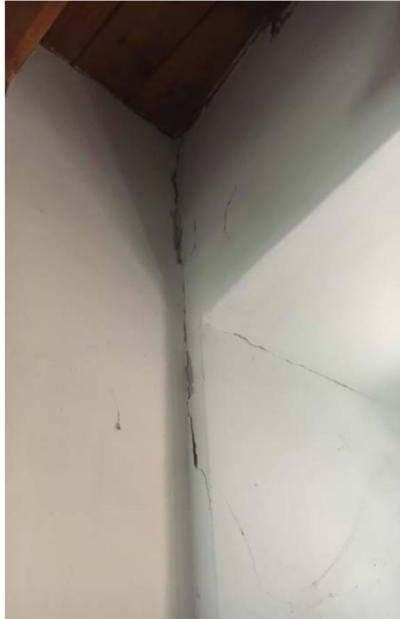
FOTO 18 E FOTO 19 INCROCIO MURO DI SPINA E PERIMETRALE PIANO SECONDO
