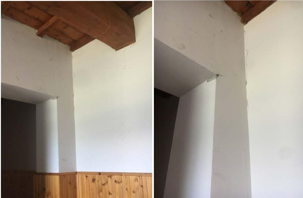
FOTO 7 E FOTO 8 INCROCIO MURO DI SPINA E PARETE PERIMETRALE PIANO SEMINTERRATO
