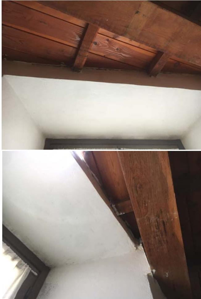
FOTO 44 E FOTO 45 SFILAMENTO TRAVETTI PIANO PRIMO
