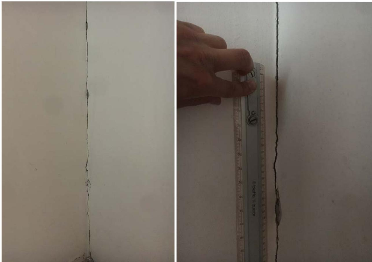
FOTO 8 E FOTO 9 INCROCIO MURO DI SPINA SCALA E PERIMETRALE PIANO TERRA
