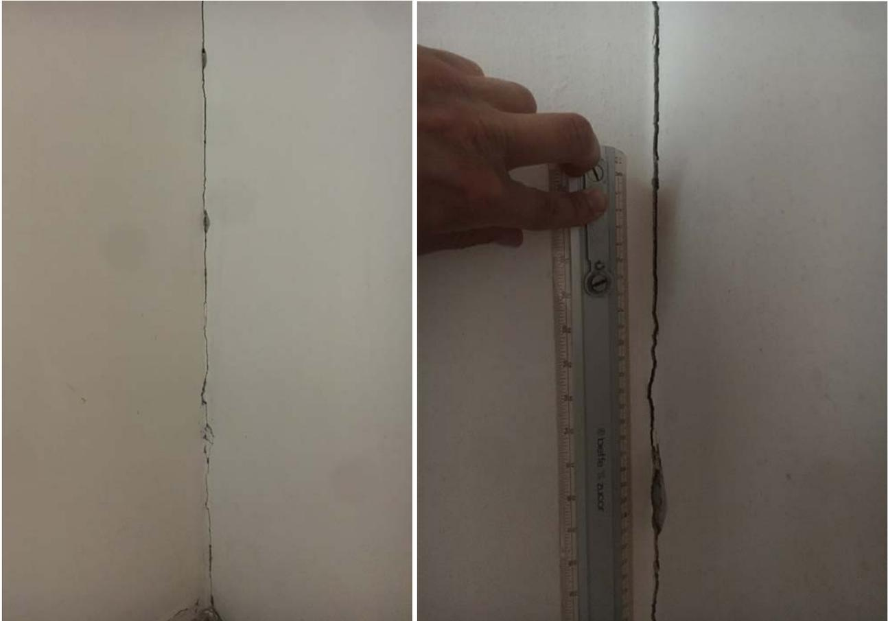
FOTO 16 E FOTO 17 INCROCIO MURO DI SPINA SCALA E PERIMETRALE PIANO TERRA
