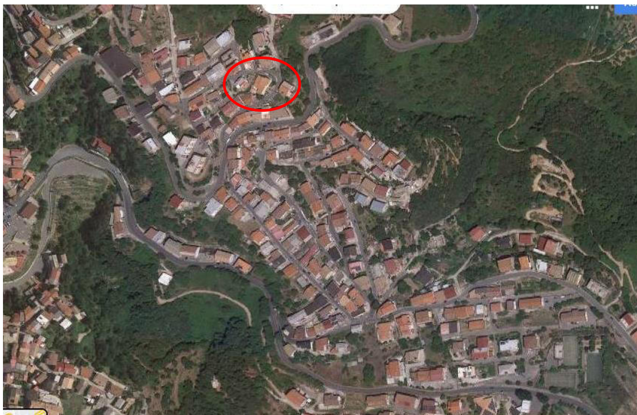
Figura 1 – posizione del complesso nel contesto urbano
