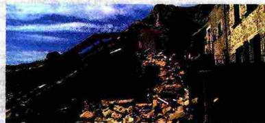
**FOTO 9 -** Diverso comportamento a brevissima distanza: Montegallo, frazione Colle. L'edificio crollato si trova a pochi metri da uno rimasto integro, che, per inciso è lo stesso della foto 5. Stessa conformazione strutturale dell'edificio di Amatrice visto in precedenza (foto 8).
