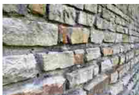
Revisione del Testo Unico dell'Edilizia: si parte
