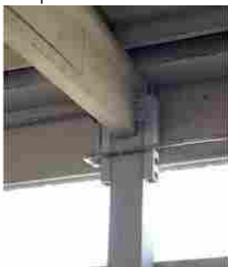
Connessione di tipo rigido, sovrar resistente
