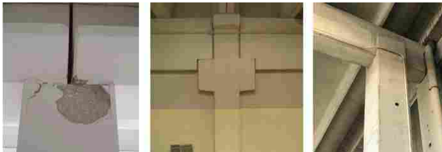
Esempi di appoggi con funzionamento ad attrito
