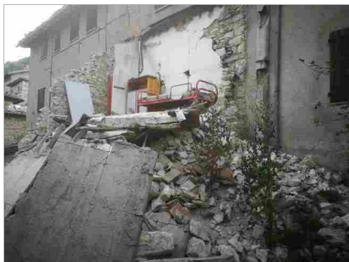
Una casa completamente distrutta a San Placido, frazione di Ussita
