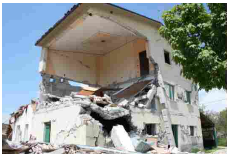
Figura 4. Crollo (quasi) completo di un edificio con copertura pesante
