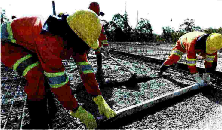
Appalti. Al via i lavori della commissione speciale del Consiglio di Stato per la scrittura del nuovo codice
