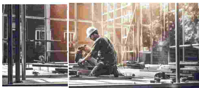
Qui sopra e a sinistra due immagini di cantieri edili (foto imageconomica)
