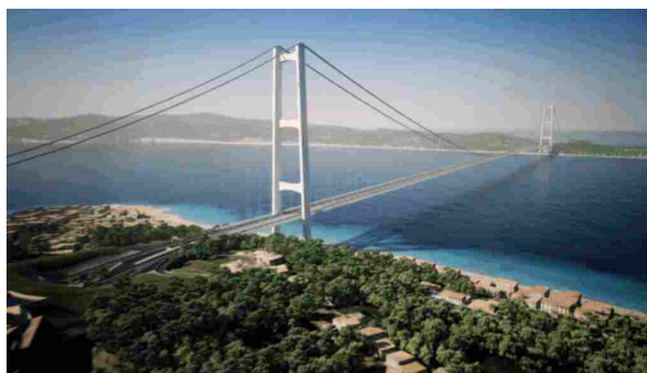
Il Ponte sullo Stretto di Messina avrà una campata unica di 3,3 chilometri, la più lunga al mondo
