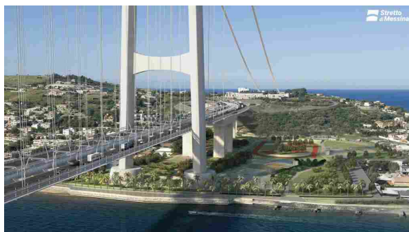
Per il ministro delle Infrastrutture Matteo Salvini, il ponte sarà "un acceleratore di sviluppo"
