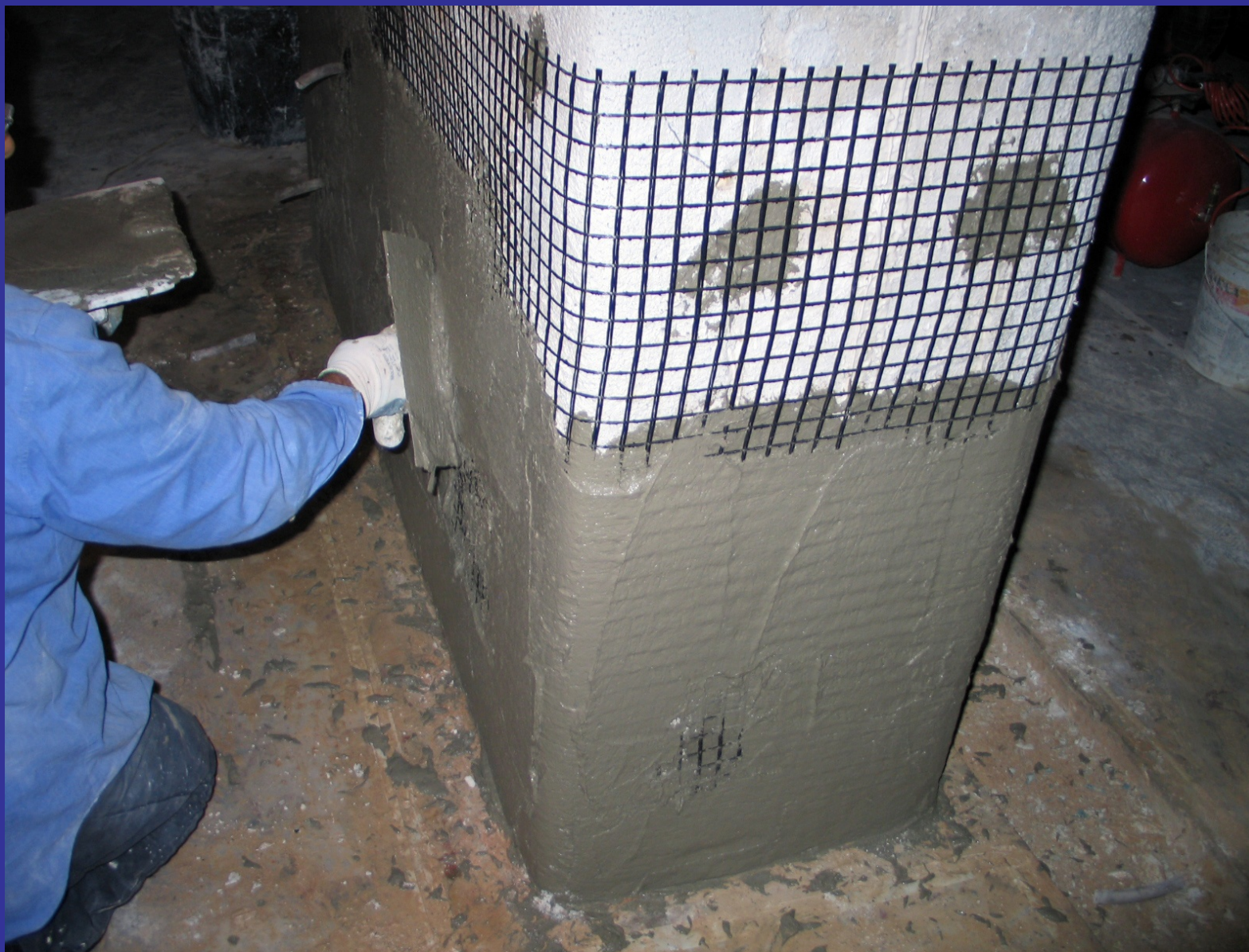
Applicazione rete in fibra di vetro e del secondo strato di malta bicomponente ad elevata duttilità
