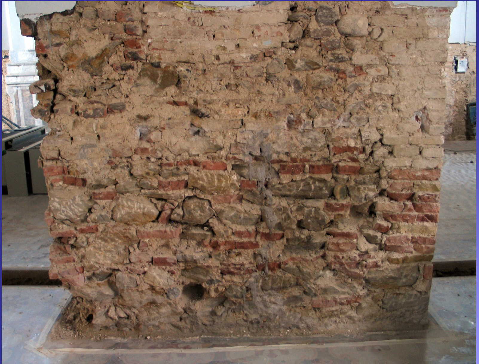
Tessitura muraria originaria del pilastro tipo
