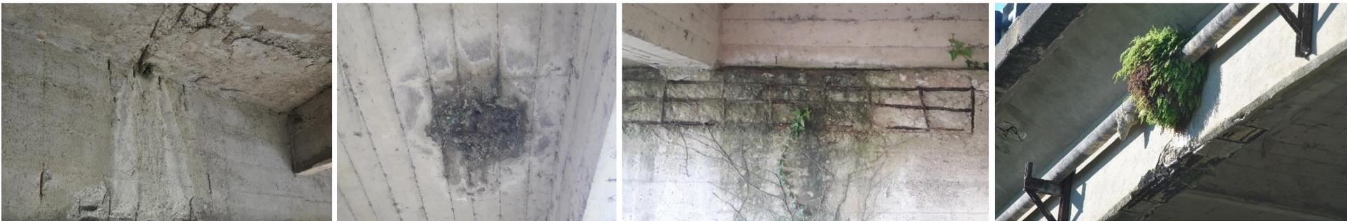
Dalle ispezioni condotte è emersa l'importanza di una **corretta manutenzione del sistema di smaltimento delle acque piovane** per evitare che il continuo contatto con l'acqua provochi dilavamento di calcestruzzo e penetrazione di agenti aggressivi con conseguente ossidazione delle barre di armatura.
