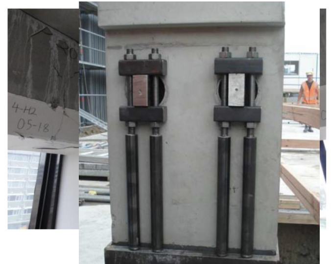
Connessione nell'edificio Alan MacDiarmid in Nuova Zelanda (Pampanin, 2010)
