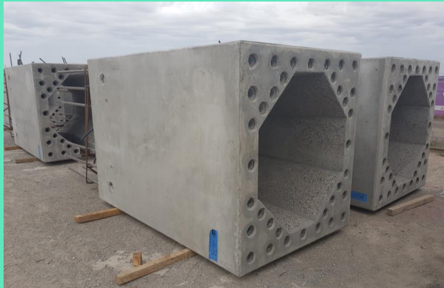
Precast Mega Columns
