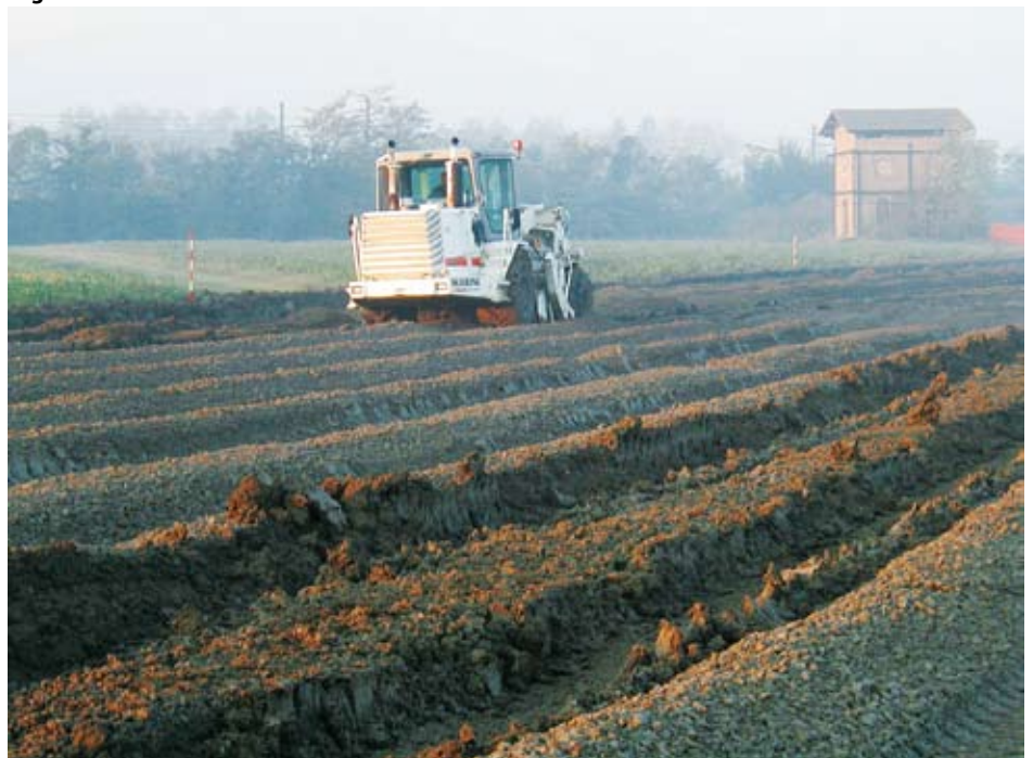
Figura 10 - Fresatura terreno in sito
