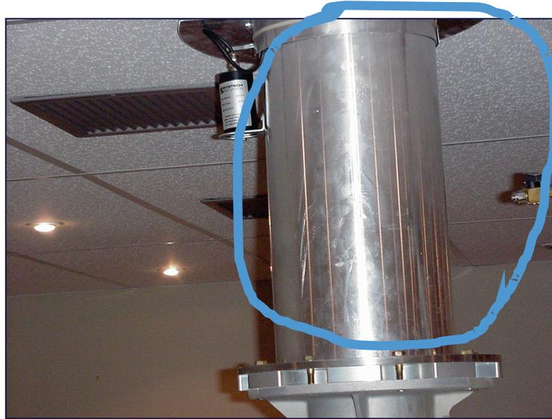
Fuoriuscita all'esterno dei fluidi criogenici gassosi a seguito di un quench: importanza di una corretta progettazione e realizzazione a regola d'arte della tubazione
