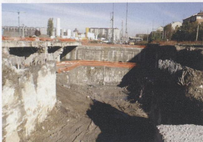
Fig. 46 - Scavo per costruzione solettoni galleria di sottoattraversamento del fiume Dora.
