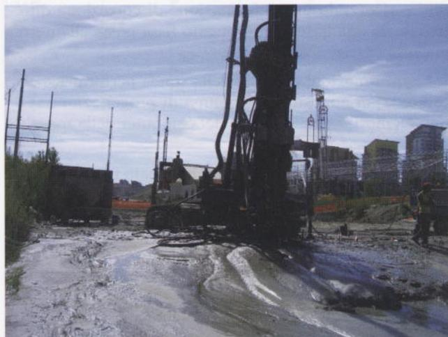
Fig. 26 - Vista dello spurgo e della conseguente sedimentazione.
