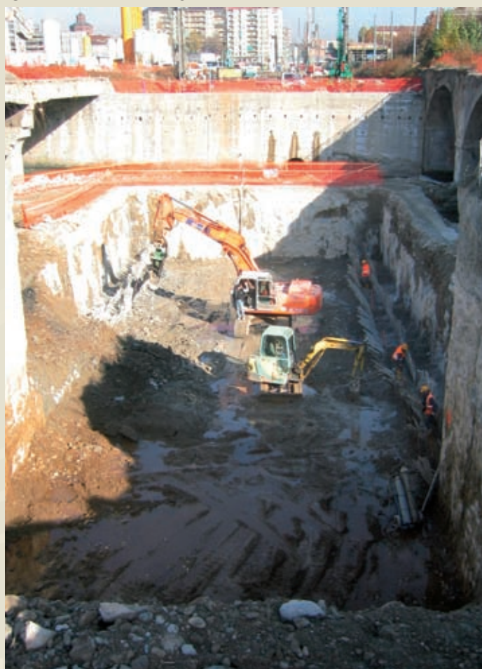
Figura 12 - Scavo solettone galleria di sottoattraversamento del Fiume Dora
