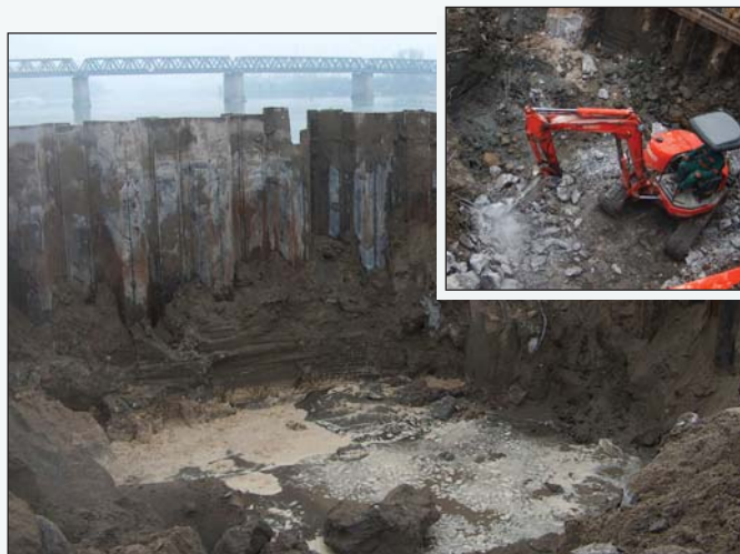
Figura 18 - Il fondo scavo
