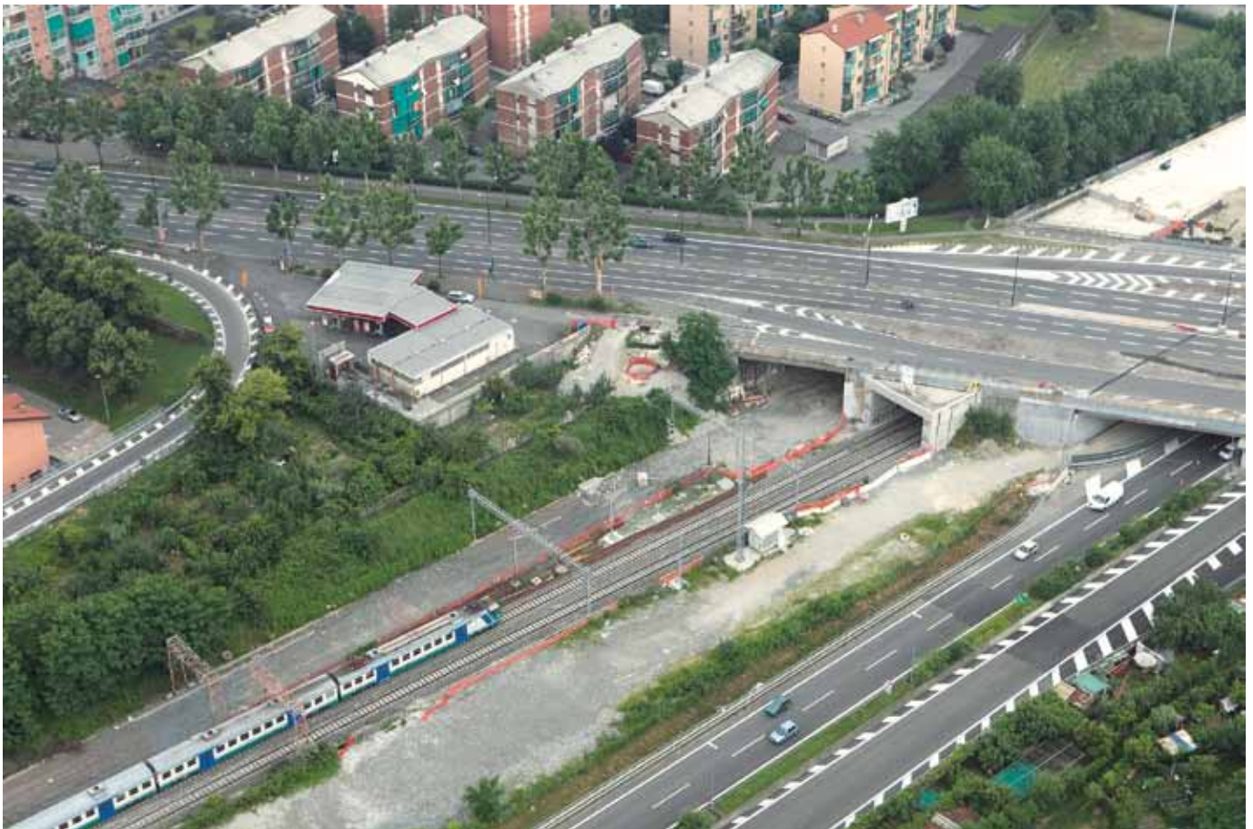
Figura 3 - Uscita gallerie a Corso Grosseto
