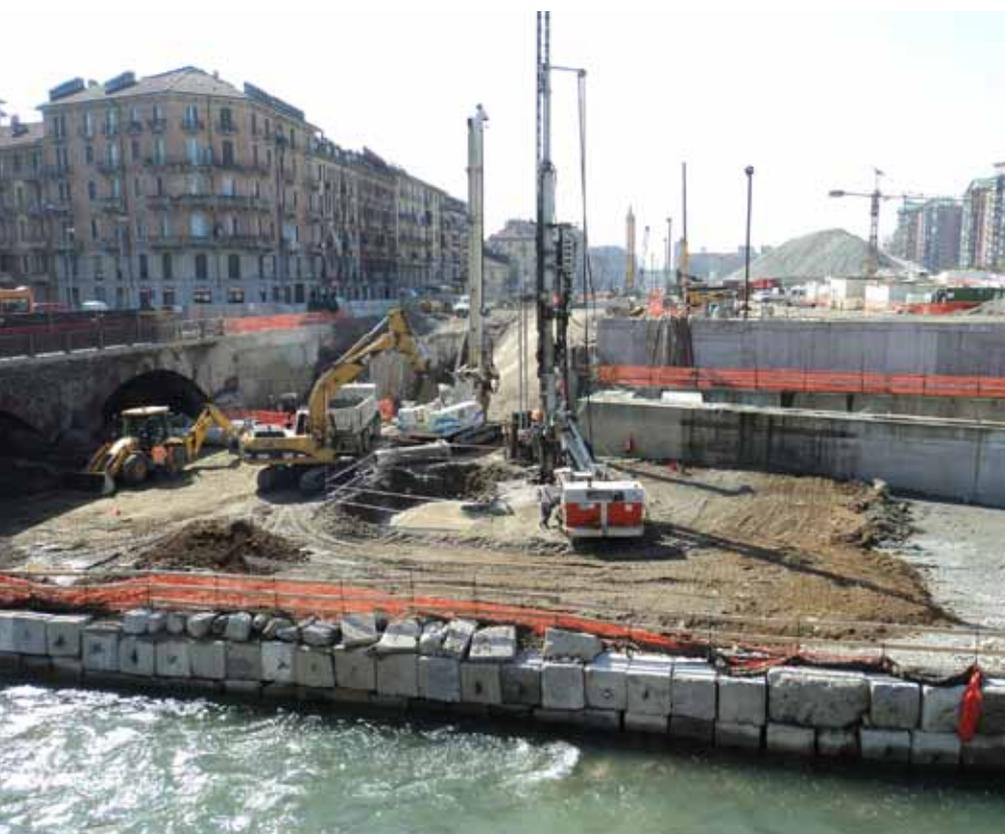
tenuto dalla compenetrazione delle colonne di consolidamento e valutare l'omogeneità costruttiva dell'intervento. La metodologie applicate avevano permesso di individuare, mediante sistemi di indagine non invasiva, la presenza di eventuali discontinuità, cavità, aperture "passanti" nel suo interno o locali anomalie di continuità delle caratteristiche del tappo di terreno consolidato.
