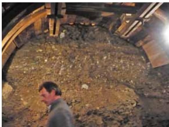
Figura 19 - Fronte scavo collettore fognario
