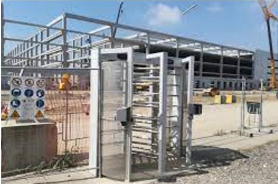
**L'organizzazione e la sicurezza in cantiere è il sistema di controllo degli accessi pedonali strutturato in modo da garantire l'ingresso al solo personale autorizzato e provvisto dei documenti necessari in base alle regole di cantiere (badge con tecnologia RFID; QR CODE; tag con tecnologia attiva; dati biometrici).**
