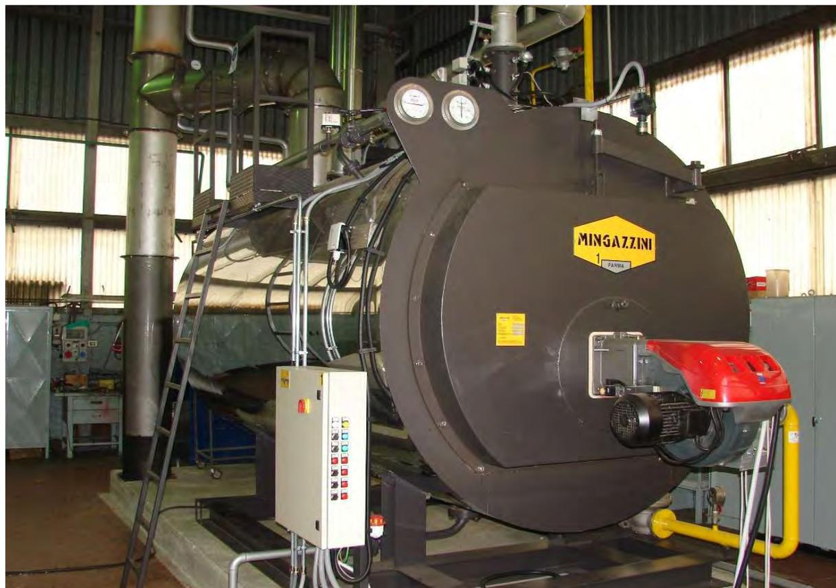
Generatore di acqua surriscaldata Mingazzini Pot. Termica al Focolare 2,32 MW, temperatura massima di esercizio 191,5 ° C. Contenuto d'acqua 5500 litri
