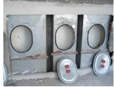
La **dimensione delle aperture è anch'essa determinata in funzione della grandezza della condotta e tabellata dalle norme tecniche**.
