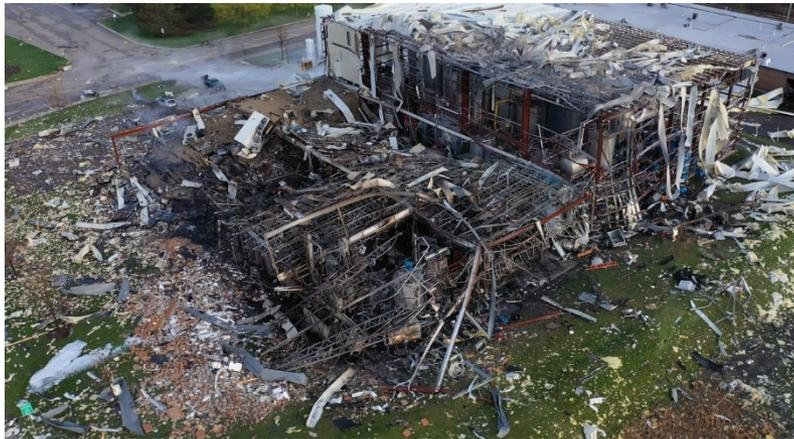
L'intensità dell'esplosione dipende anche dal grado di confinamento: le esplosioni che hanno luogo in spazi confinati sono più severe.
