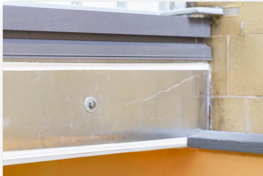
Connessione con barra filettata zincata saldata
