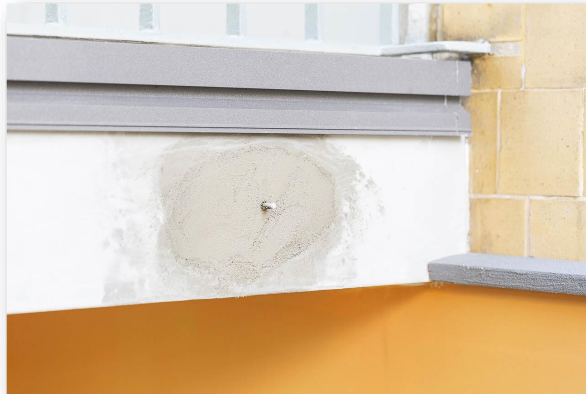
Connessione con barra filettata zincata saldata
