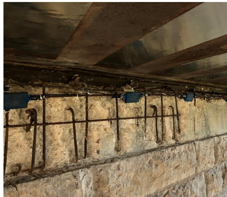
Protezione catodica galvanica
