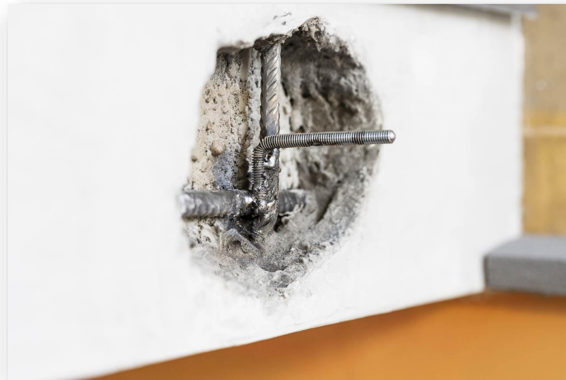
Connessione con barra filettata zincata saldata
