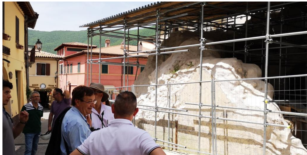
Malta a base di calce idraulica naturale fibrata applicata a spruzzo
