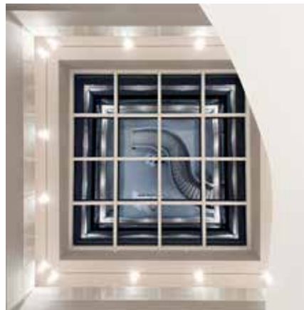
Luce zenitale copertura trasparente e ballatoi a tutta altezza
