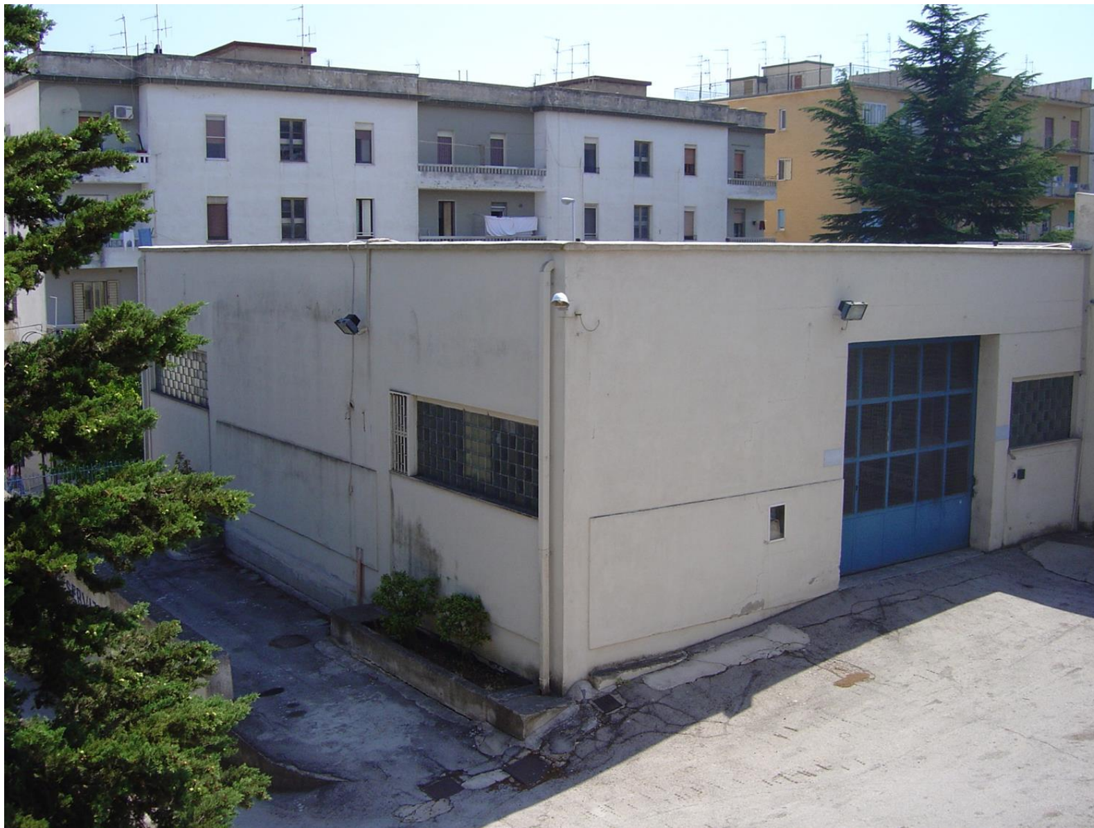
Edificio in via Lucana (MT), prima degli interventi di demolizione e ricostruzione. 2007
