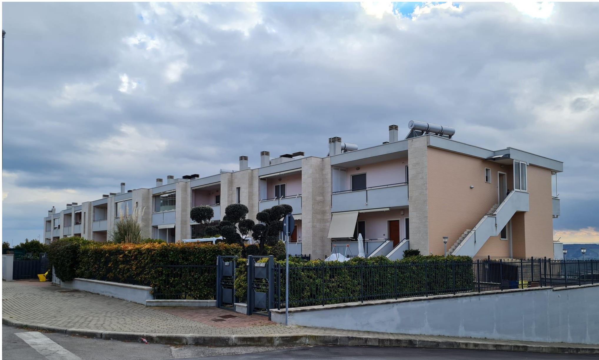
Complesso in via M. Biagi (MT) dopo l'intervento di demolizione e ricostruzione
