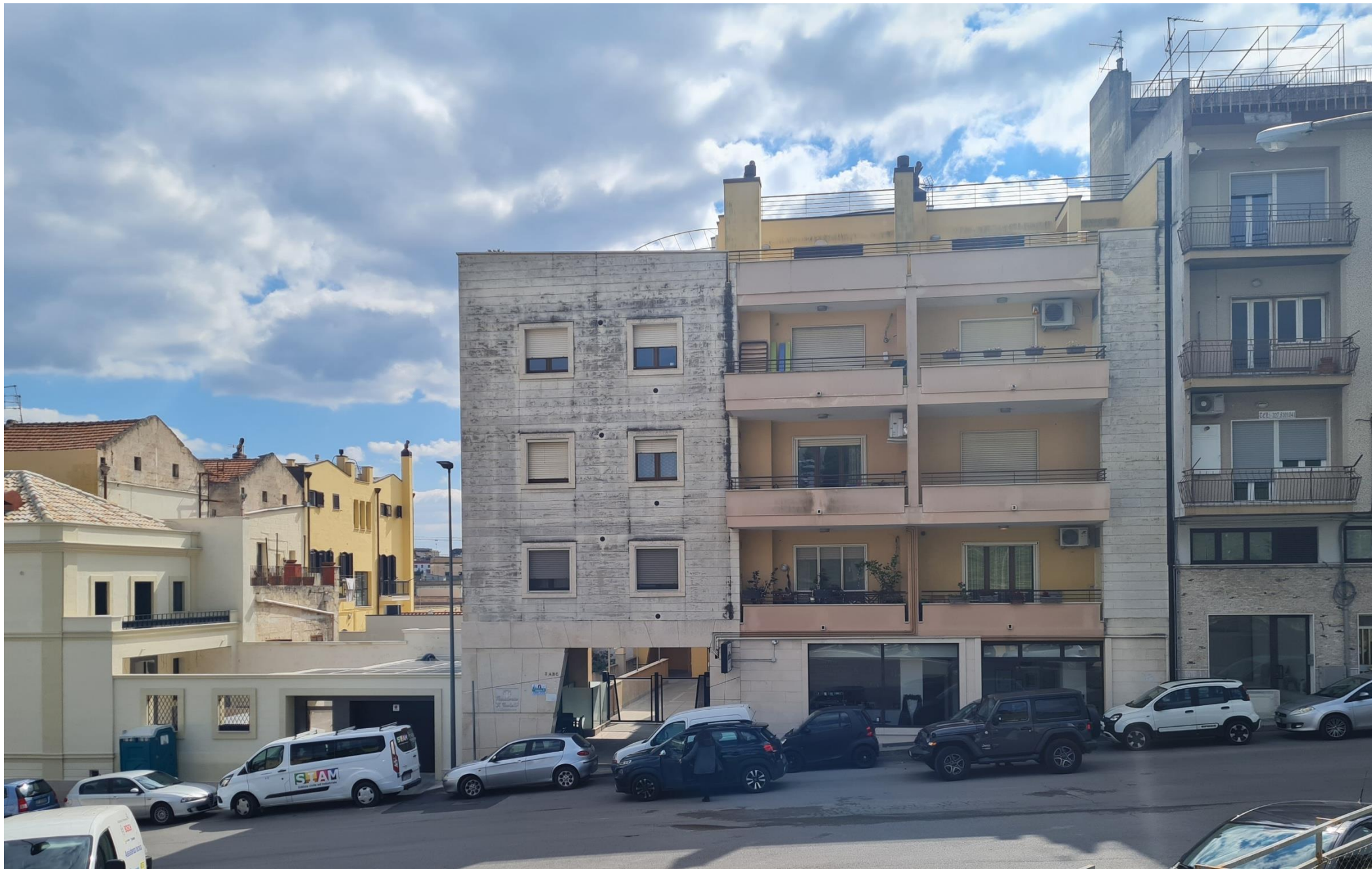
Edificio in via Lanera (MT) dopo l'intervento di demolizione e ricostruzione
