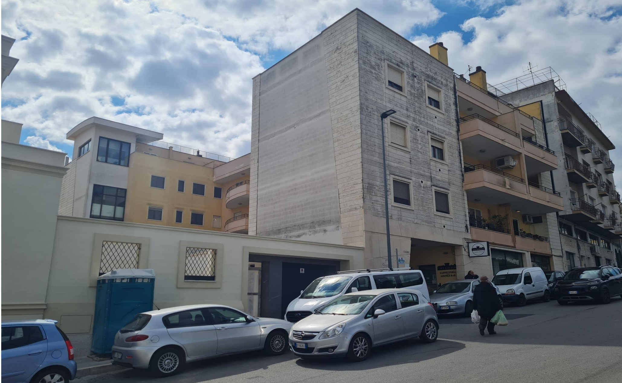
Edificio in via Lanera (MT) dopo l'intervento di demolizione e ricostruzione
