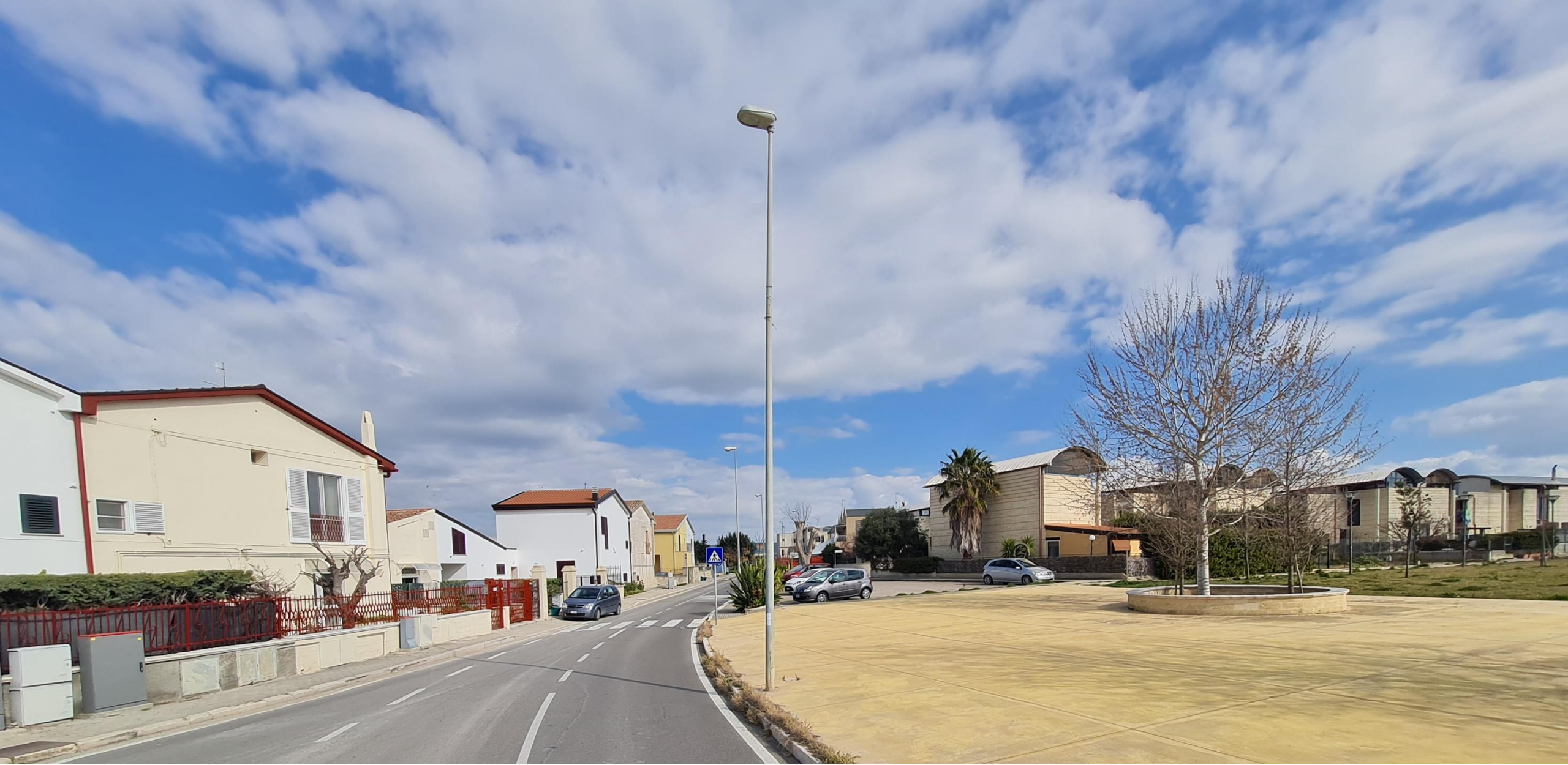
Borgo La Martella oggi. Gli edifici originari (a sinistra) e l'ampliamento moderno (a destra)
