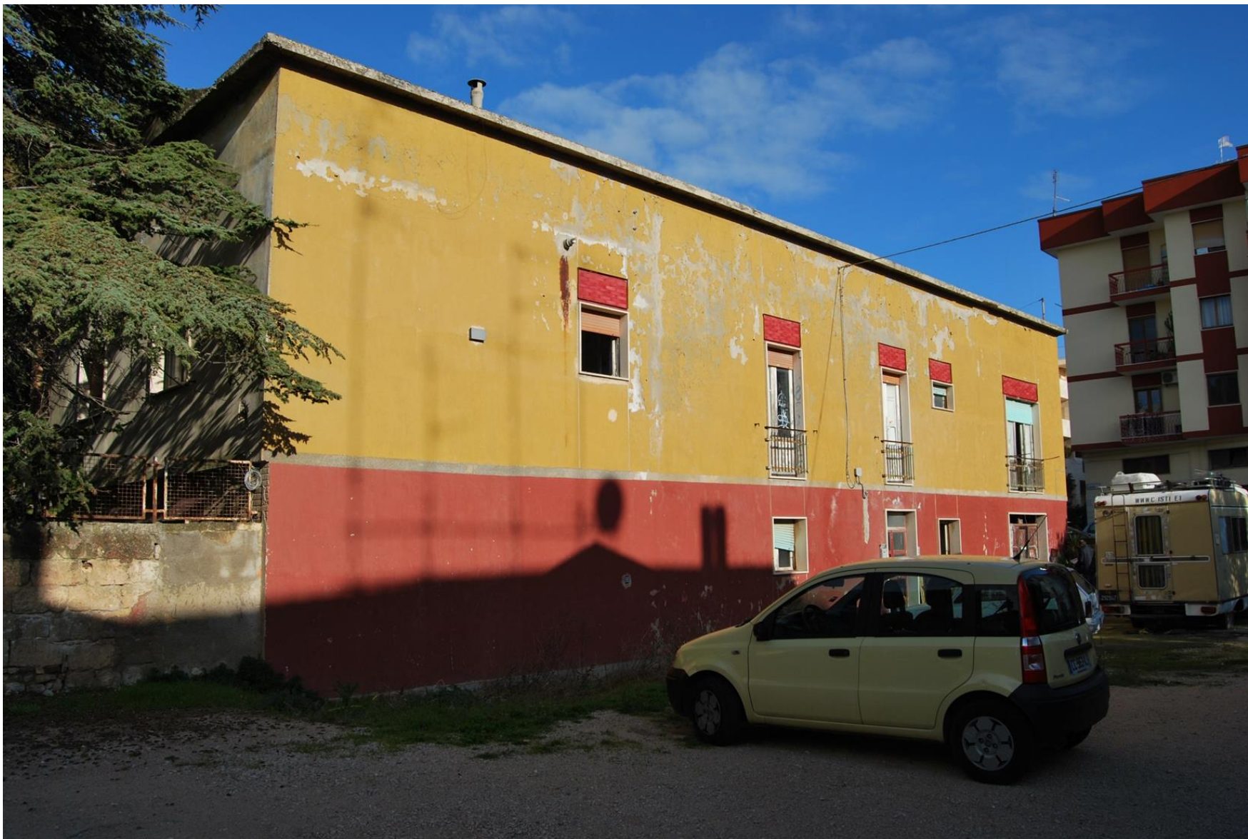
Edificio in via Gattini, (MT), prima degli interventi di demolizione e ricostruzione. 2010
