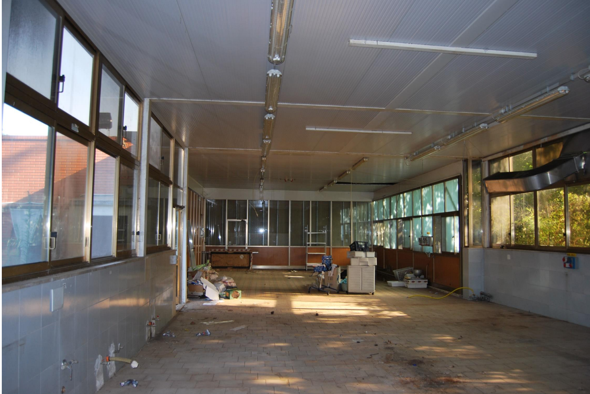
Edificio in via A.M. Di Francia (MT) prima del progetto di demolizione e ricostruzione. 2019
