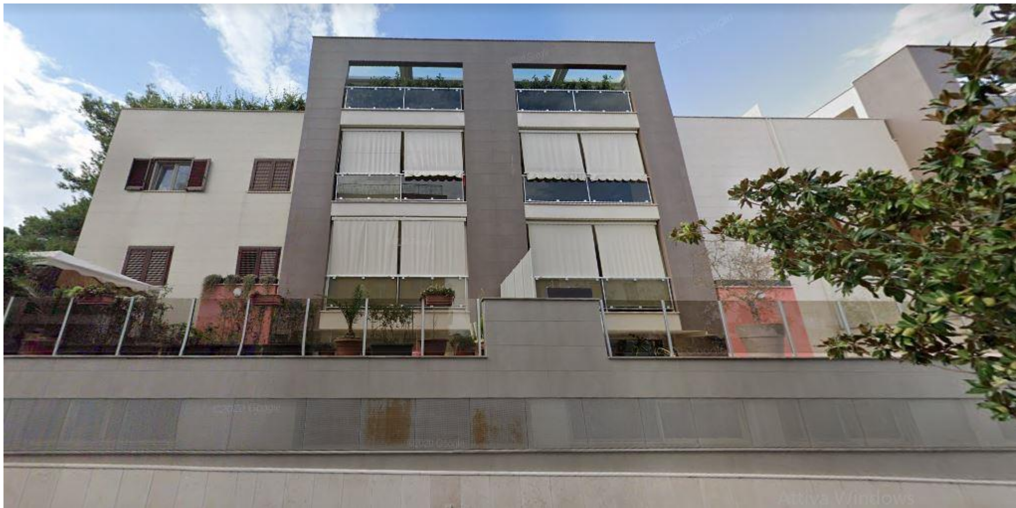
Edificio in via Lucana (MT) dopo il progetto di demolizione e ricostruzione. 2022
