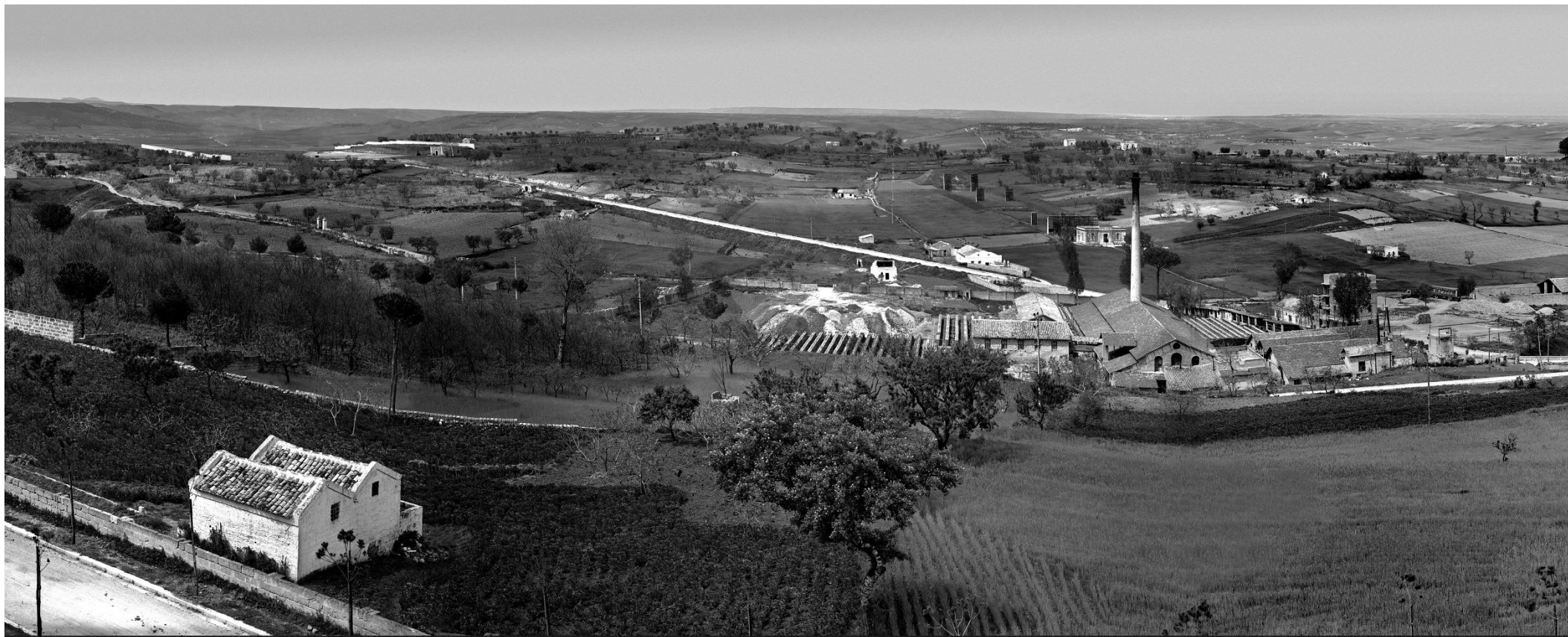
1950, Veduta di Serra Venerdi prima della costruzione del quartiere. Archivio G. Buonsanti
