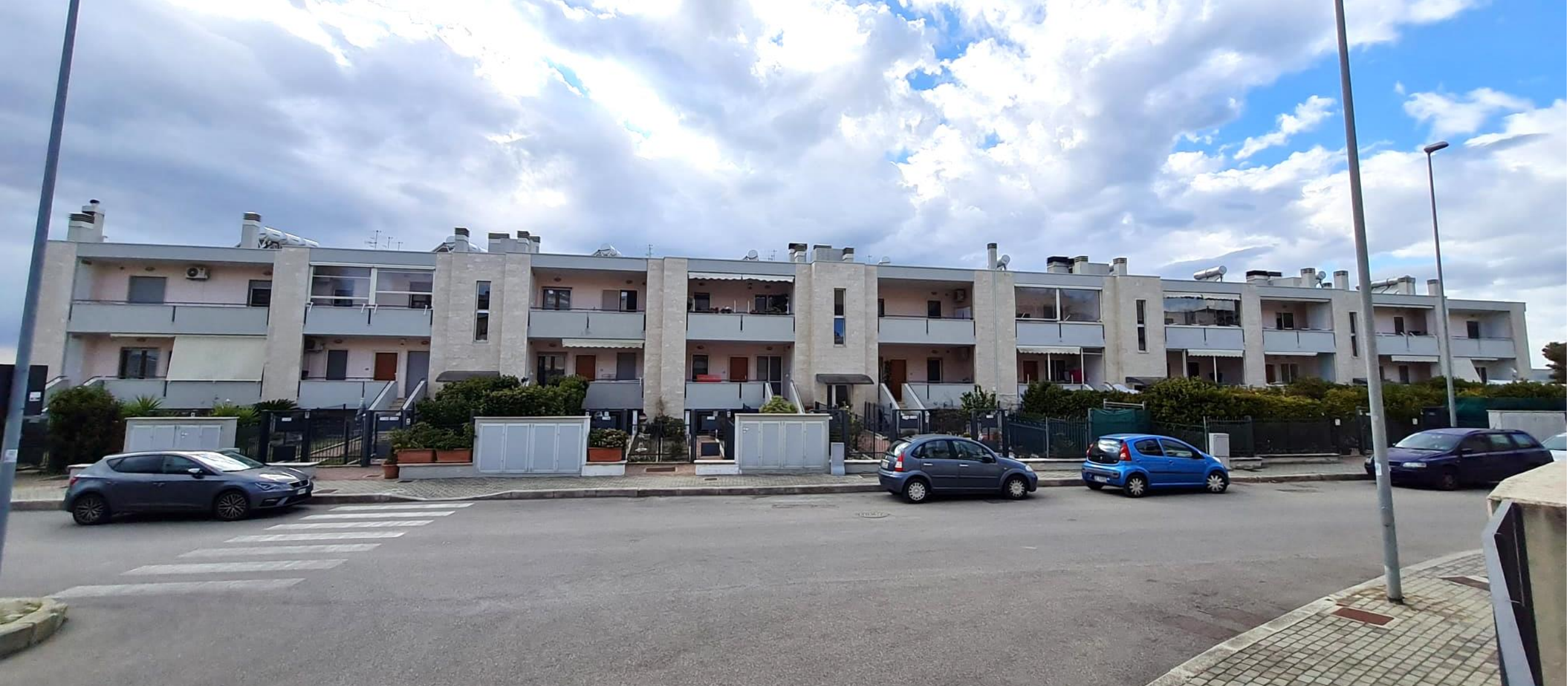
Complesso in via M. Biagi (MT) dopo l'intervento di demolizione e ricostruzione
