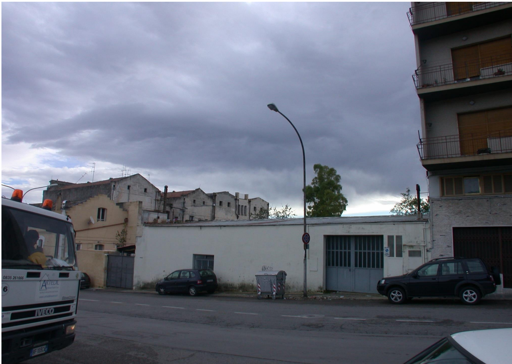
Edificio in via Lanera (MT) prima del progetto di demolizione e ricostruzione. 2007
