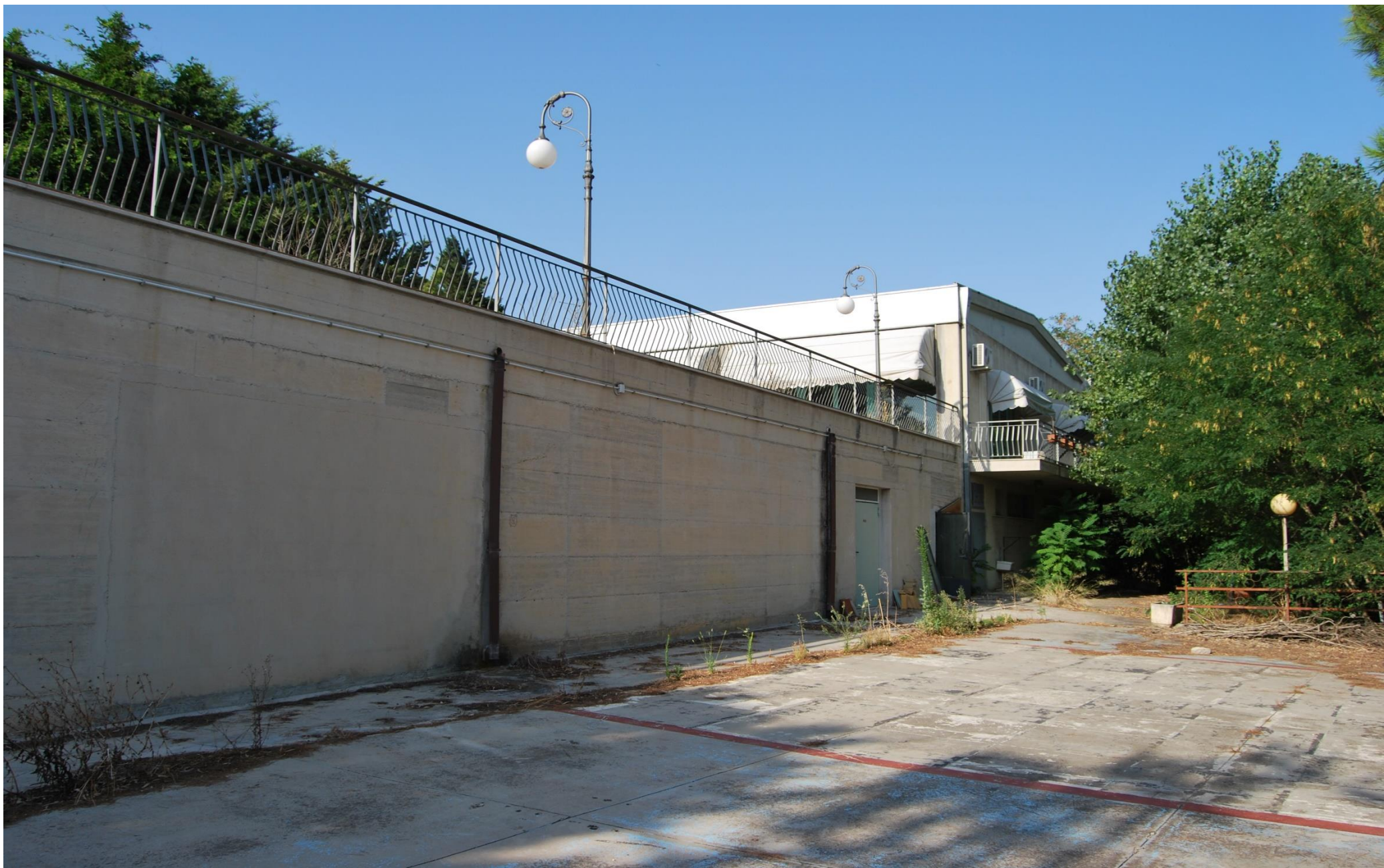
Edificio in via A.M. Di Francia (MT) prima del progetto di demolizione e ricostruzione. 2019
