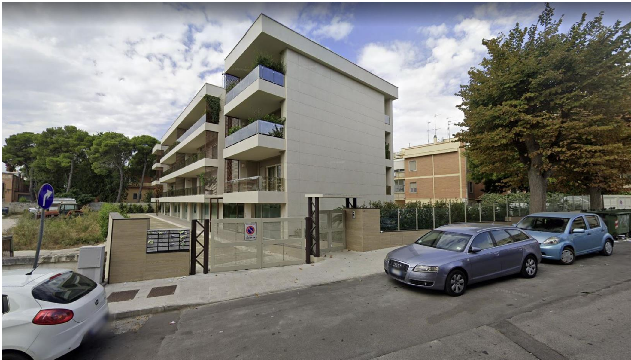
Edificio in via Gattini (MT) dopo il progetto di demolizione e ricostruzione
