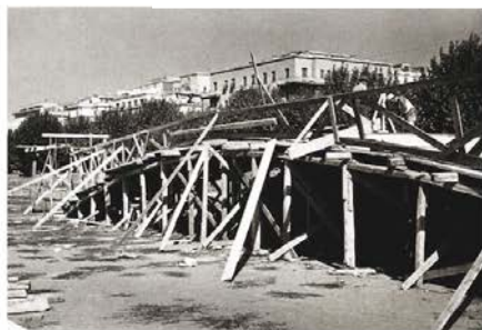
4a. Realizzazione della struttura lignea di so
