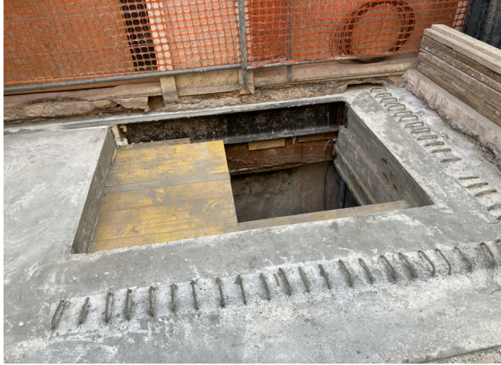
Foro con profilo di tenuta autocentrante predisposto
