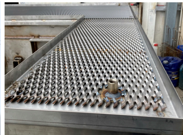
Particolare strato di allettamento in lamiera stirata all'interno di vasca a totale tenuta in acciaio inox
