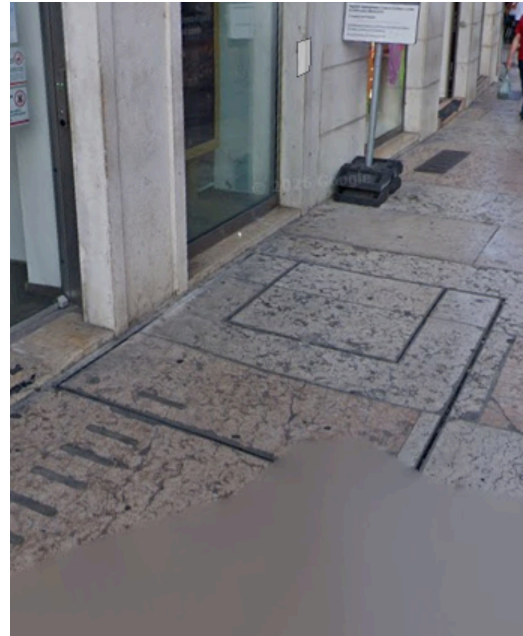
Situazione dopo l'intervento (attuale): sono state rimontate le stesse mattonelle esistenti
