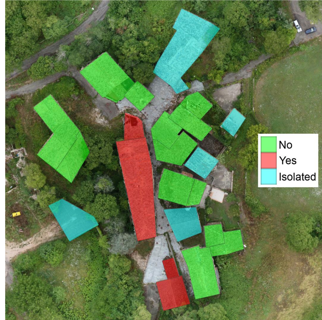
Presenza di edifici adiacenti con altezze diverse
