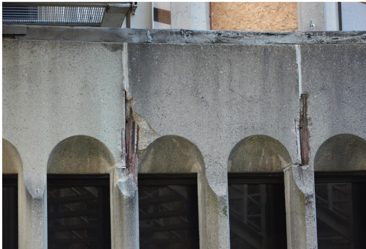
Espulsione del copriferro sulle facciate dell'edificio
