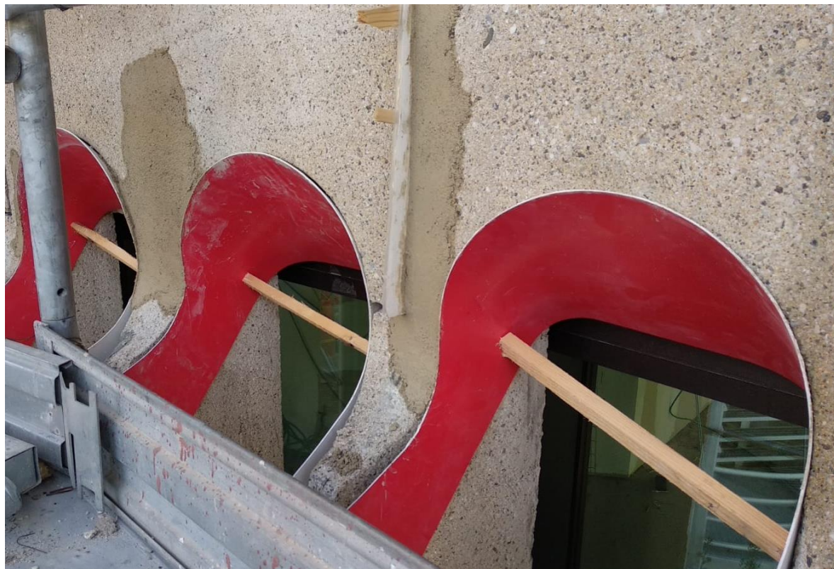
Inserimento delle casseforme per alcuni degli interventi in facciata
