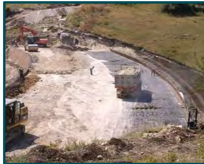
2. Transitare con i veicoli sopra i rinforzi
