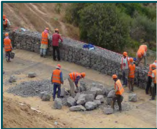
1. Spaccare massi sopra i rinforzi
