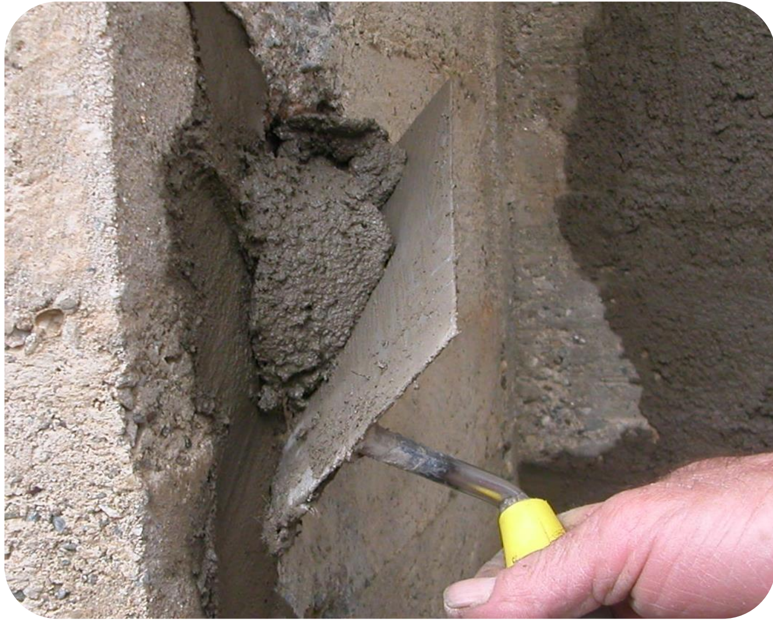
Applicazione malta e realizzazione finitura
