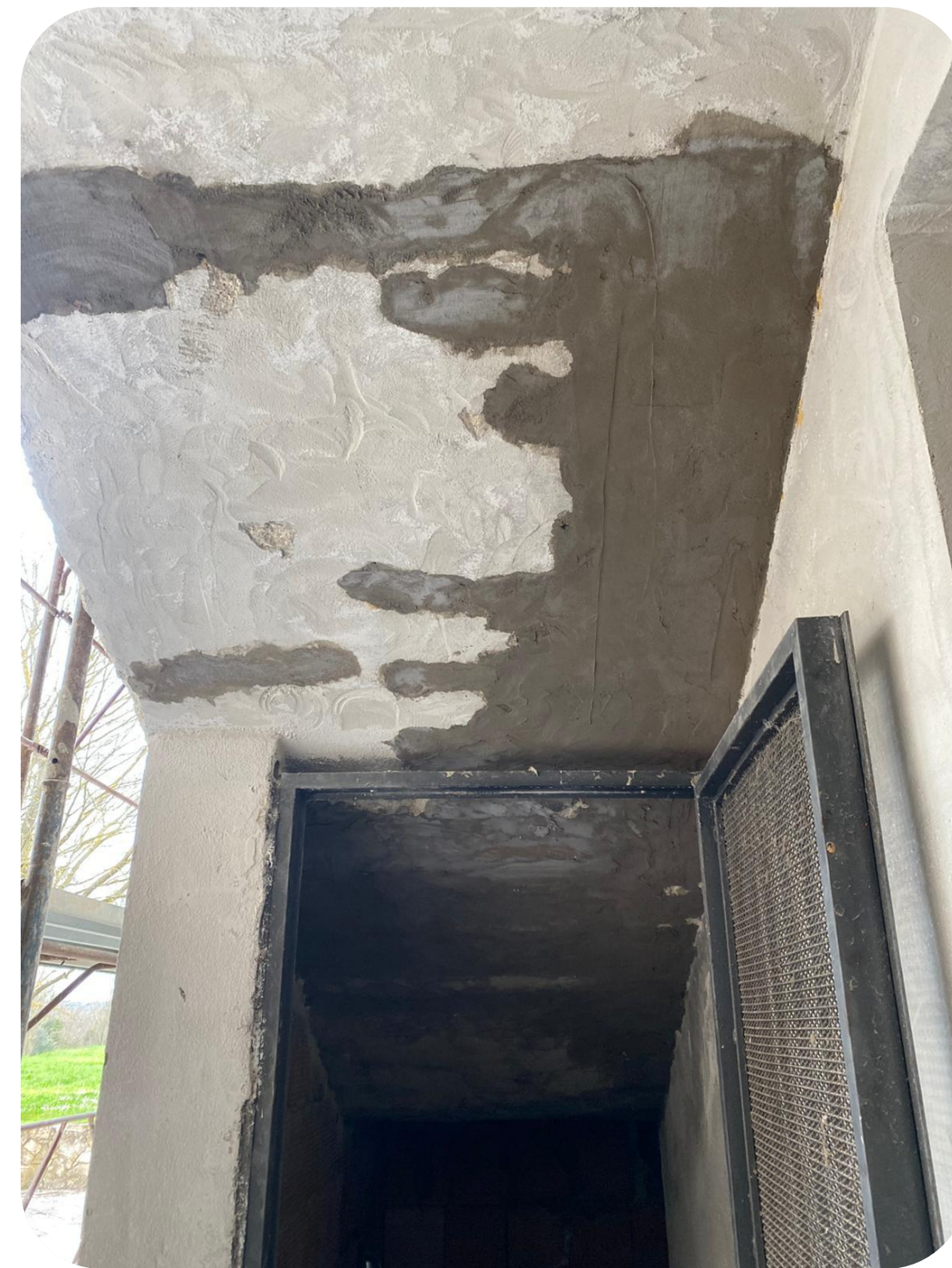
Ripristino corticale e rasatura Con malta polifunzionale
