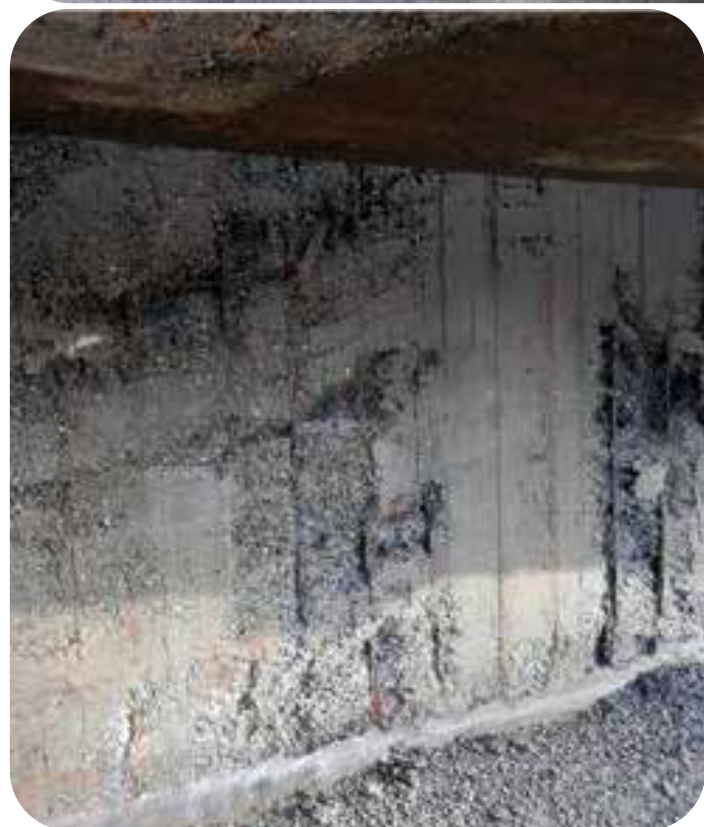
Erosione Abrasione
