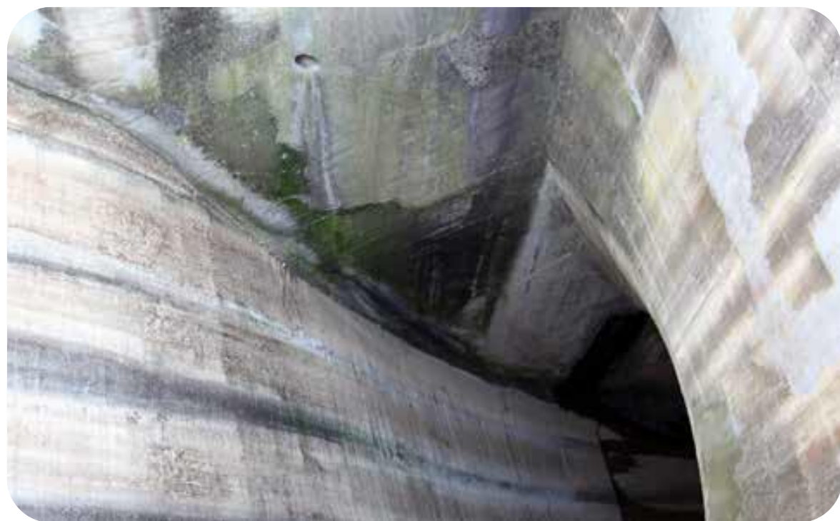
Erosione Abrasione
