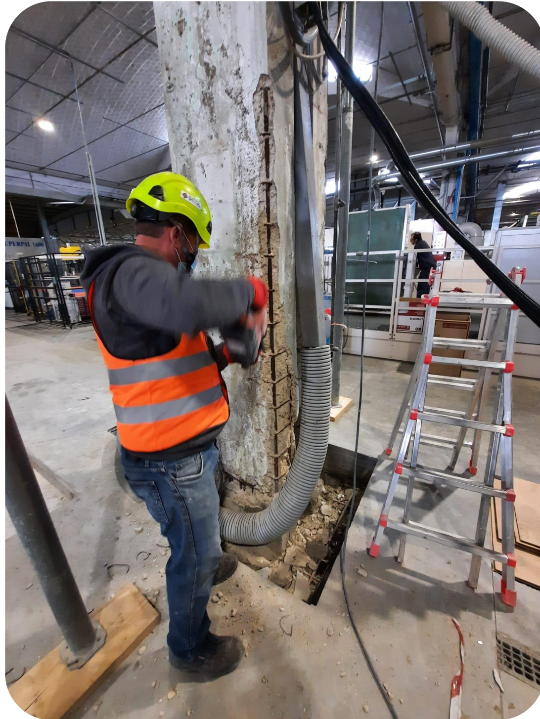
Rimozione cls degradato
