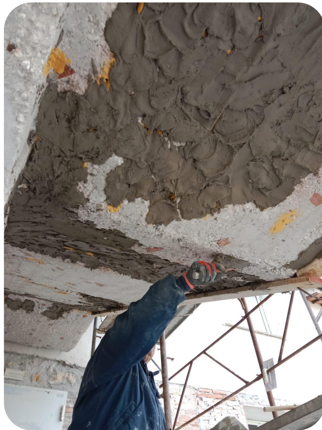
Ripristino corticale e rasatura Con malta polifunzionale
