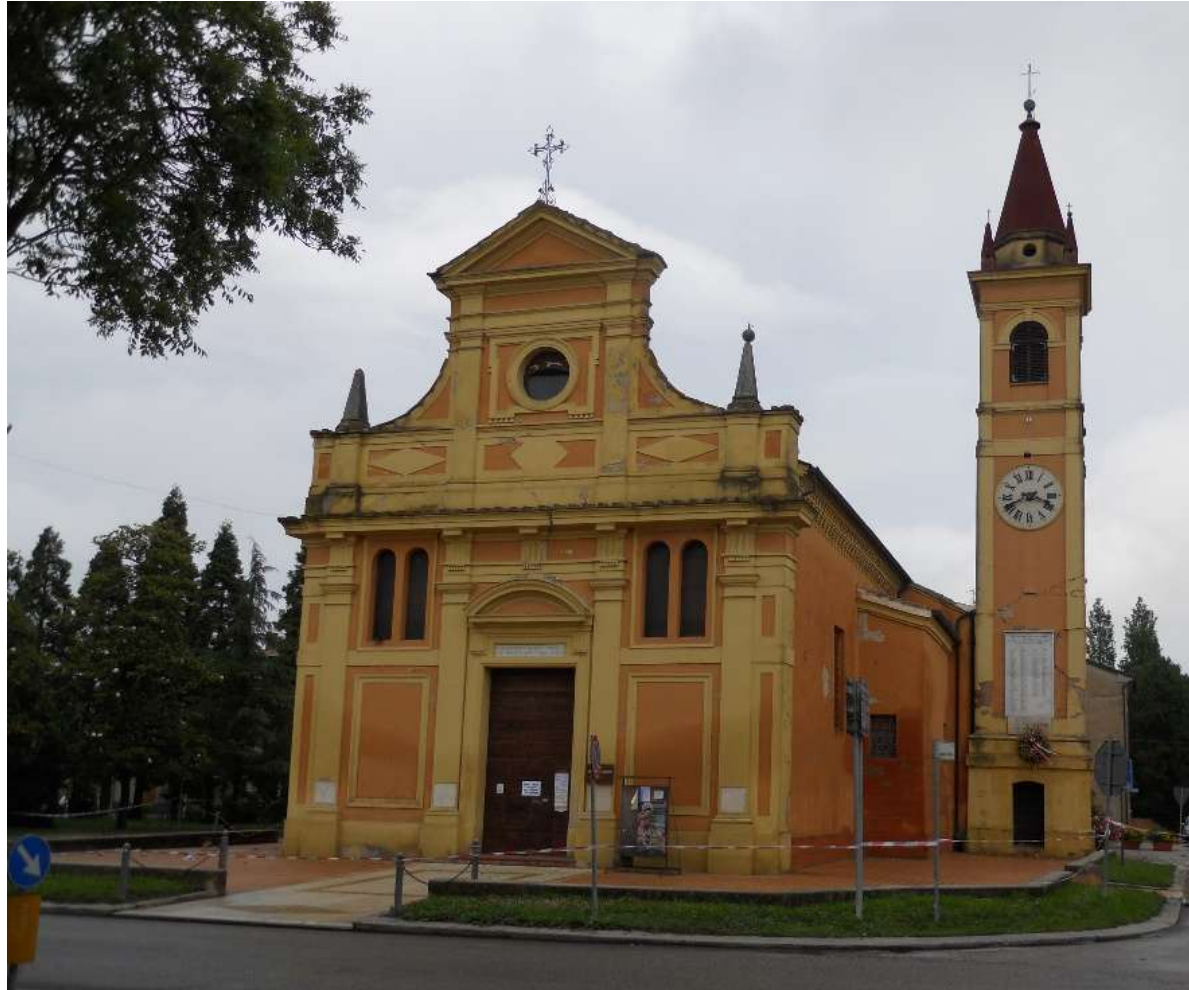
Chiesa e campanile di San Lorenzo (Cento) – interazione del campanile con la chiesa
