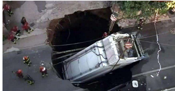
...la strada ha inghiottito un camion della spazzatura... (Casalmuro, Napoli - 10 agosto 2011)
