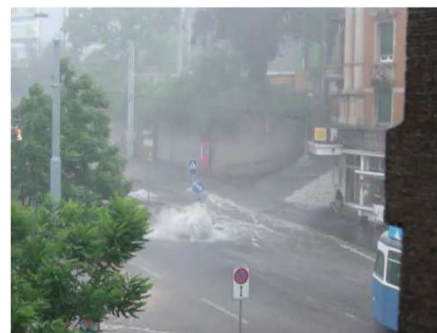
Sewer geysier in uscita da un pozzetto lungo Universitätstrasse, Zurigo
