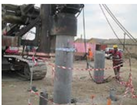
Fig. 6 Schema di prova, vista sensori e battitura del palo, unità di acquisizione PDA
