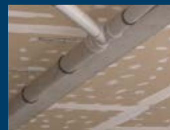
FIGURA 5. Valsir Silere®: l'eccellente sistema di scarico per l'isolamento acustico con braga miscelatrice (VBF)
