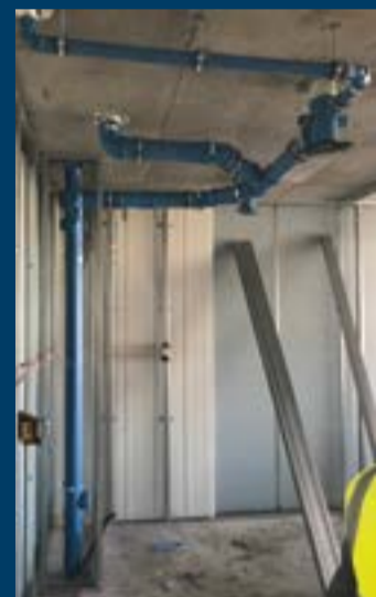
FIGURA 4. Valsir Triplus®: il sistema di scarico in triplice strato con braga miscelatrice (VBF)
