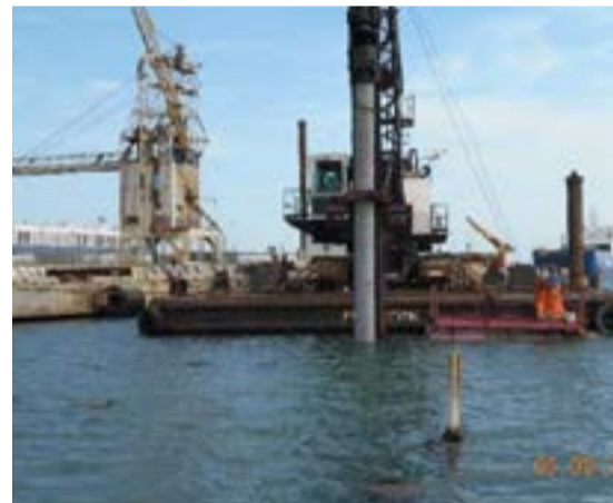
Fig. 11 Lavori di realizzazione dei pali battuti
