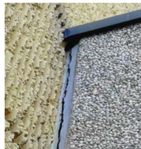
Foto 7. Contatto veletta-palazzina uffici (capannone 1). Il silicione è fessurato e si percepisce anche la rotazione della veletta.
