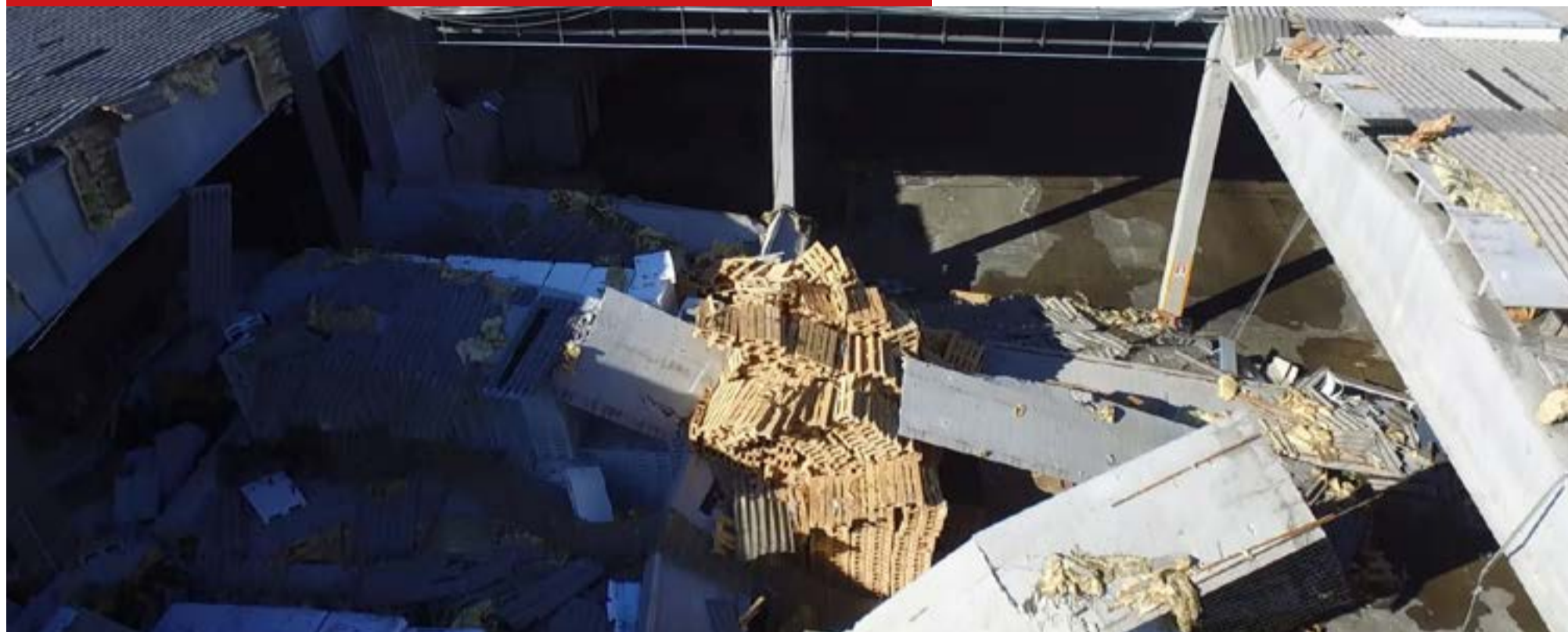
Foto 1. La porzione di copertura crollata
