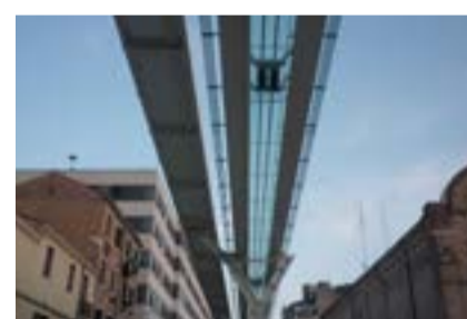
People Moover | Venezia Infrastruttura sopraelevata (dai 5 ai 7 metri) formata da due piastre lisce, sulle quali scorrono, trainati da un sistema a fune, i convogli dotati di ruote gommate. Le ruote portanti hanno l'asse orizzontale, le ruote guida hanno l'asse verticale. La fune è del tipo detto Jota ed è realizzata in acciaio speciale
