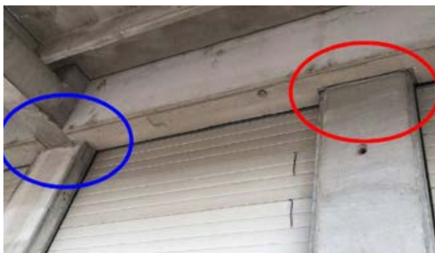
Foto 5. La pensilina dall'esterno (capannone 1). Si nota il silicione fessurato in corrispondenza dei pilastri secondari rimasti verticali (ovale rosso), e l'attacco della mensola al pilastro dove il silicione è integro (ovale blu)
