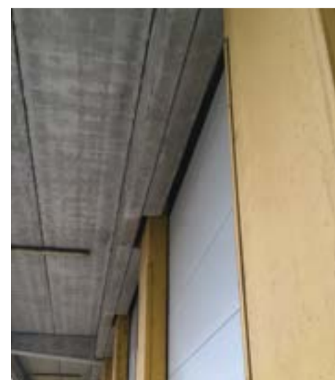
Foto 8. La pensilina dall'esterno (capannone 2). Si nota il distacco dai pilastri secondari (rimasti verticali)
