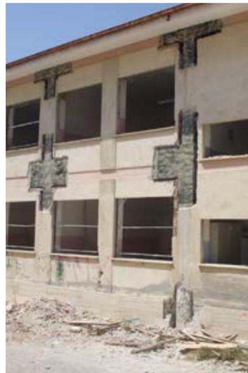
Fig. 10 - Ricostruzione privata a L'Aquila. Rinforzo dei nodi trave-pilastro
