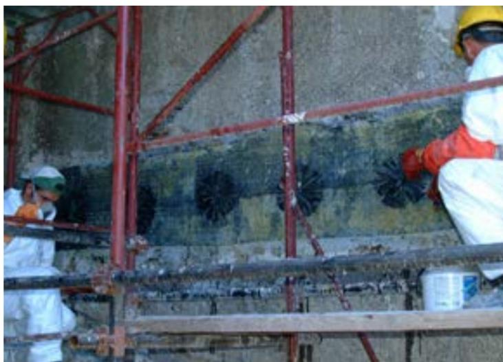
Fig. 5 - Connessioni travi/pilastri con ancoraggi a fiocco al filo esterno murario.
