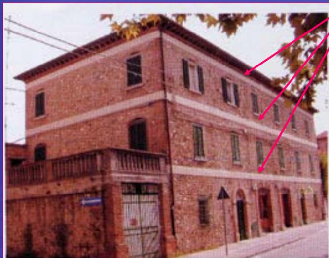
Fig. 3 - Incatenamento realizzato con compositi
