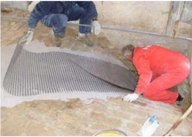
Fig. 7 - Lastra di spessore molto ridotto in FRCM
