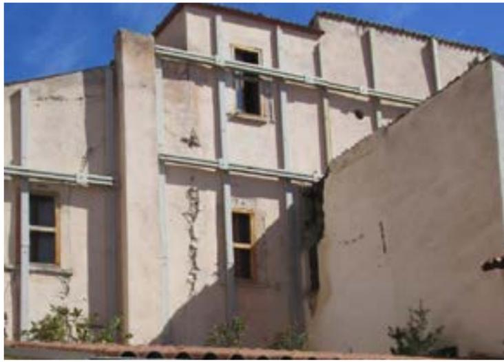
Fig. 8 - Eliminazione dei meccanismi di primo modo. Intervento post-sisma nella regione Abruzzo in edificio del centro storico de L'Aquila ad uso abitativo con esito tipo E - «Consorzio piazzetta del Cardinale» - U.M.I. 2. Cordolo in muratura armata
