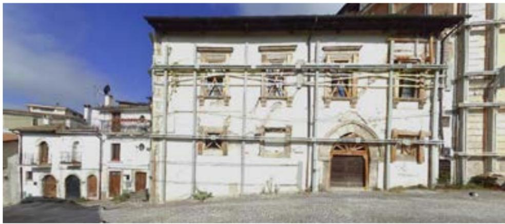
Fig. 9 - Eliminazione dei meccanismi di secondo modo. Intervento post-sisma nella regione Abruzzo in edificio del centro storico de L'Aquila ad uso abitativo con esito tipo E - «Consorzio piazzetta del Cardinale» - U.M.I. 2. Fasce di piano con FRP - tessuto quadriassiali
