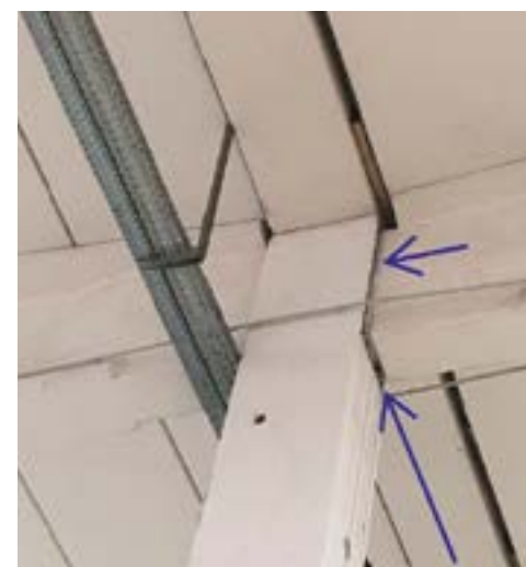
Foto 6. Un appoggio interno (capannone 2). Si nota la porzione di neoprene fuoriuscente e la diversa colorazione della trave
