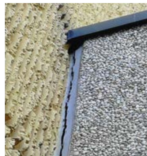
Foto 7. Contatto veletta-palazzina uffici (capannone 1). Il silicone è fessurato e si percepisce anche la rotazione della veletta.
