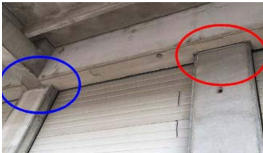
Foto 5. La pensilina dall'esterno (capannone 1). Si nota il silicone fessurato in corrispondenza dei pilastri secondari rimasti verticali (ovale rosso), e l'attacco della mensola al pilastro dove il silicone è integrato (ovale blu)
