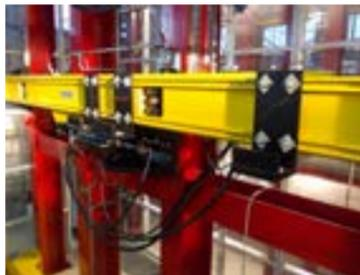
Particolare di una delle due travi sismiche
