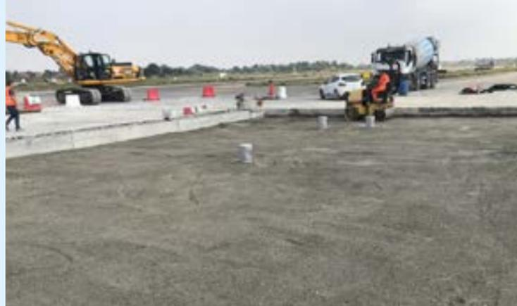
Foto 2: stesa e compattazione del materiale di fondazione
