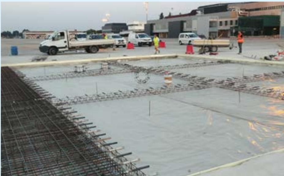
Foto 3: zona getto con disposizione di armatura
