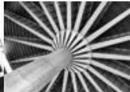
Il progetto è incentrato sulla suddivisione della copertura quadrata (22.500m) in sedici elementi indipendenti a ombrello di 40 metri di lato separati da strisce continue di lucernari e costituiti da una raggiera di travi in acciaio e da un pilastro centrale a geometria variabile, caratteristica ricorrente nelle opere di Nervi.
