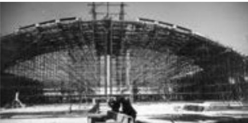
Progettato e costruito subito dopo la fine della Seconda Guerra Mondiale, il Salone B del Palazzo delle Esposizioni di Torino rappresenta la prima possibilità concreta per Nervi di applicare il principio della prefabbricazione strutturale.
