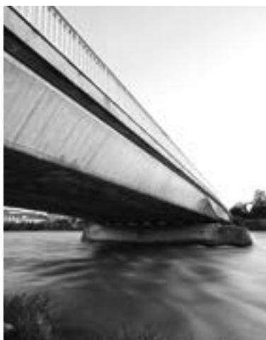
Elemento significativo del progetto è la variazione della sezione, che passa da una sagoma trapezia agli appoggi a una a trapezio capovolto in campata. Questa superficie rigata a doppia curvatura ricorre spesso nell'opera di Nervi per la sua intrinseca appropriatezza alla costruzione mediante casseri realizzati con listelli rettilinei disposti secondo una delle famiglie di rette generatrici.
