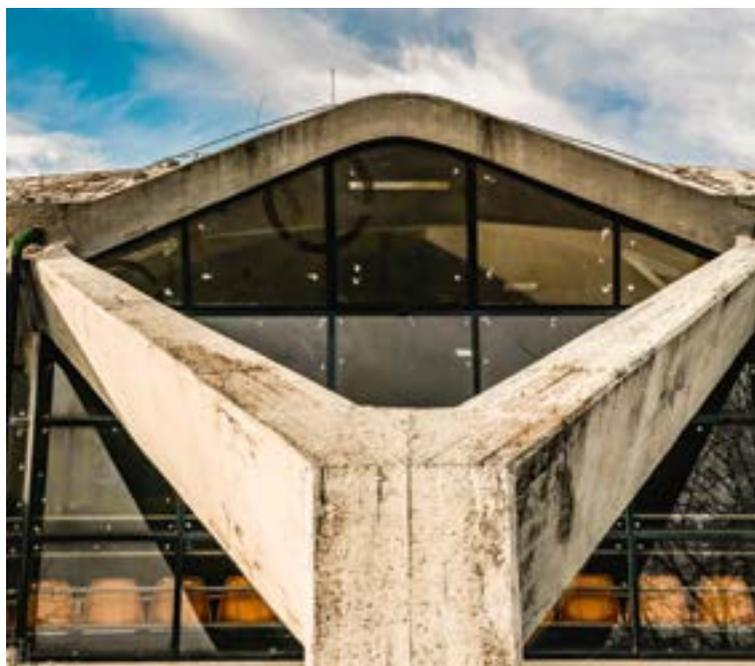
**Abolita la centina di legno, Nervi, come già a partire dalla seconda serie delle aviorimesse, scompone la calotta in pezzi da confezionare a piè d'opera, poi assemblati su un ponteggio leggero e discontinuo; nei canali tra i tavelloni viene così disposta l'armatura ed eseguito il getto di completamento. Costato appena 200 milioni di lire, è costruito in poco più di un anno.**
