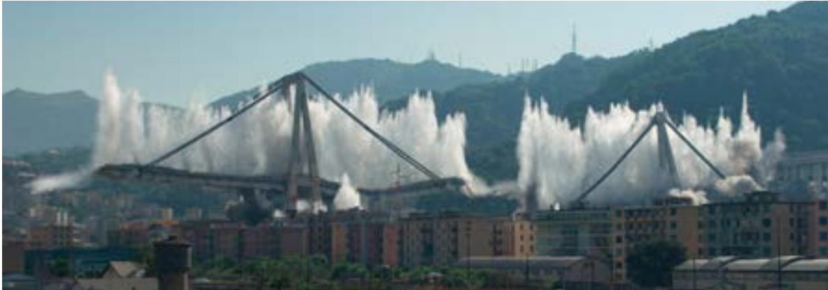
Genova, 28 giugno 2019, ore 9.37: l'esplosione delle pile 10 e 11
