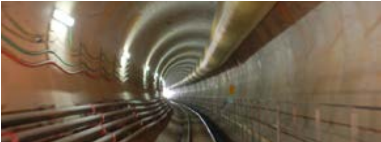
Foto 3. Galleria TBM (© Metro C scpa)
