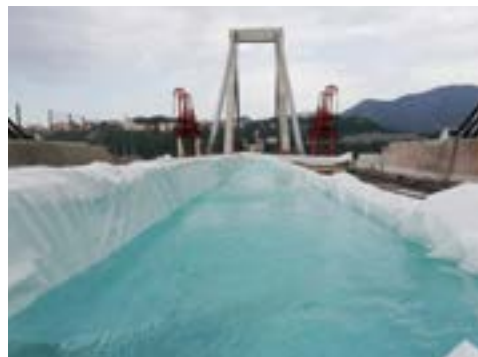
Foto 1. Una delle "piscine" sul viadotto (Fonte: http://www.commissario.ricostruzione.genova.it )
