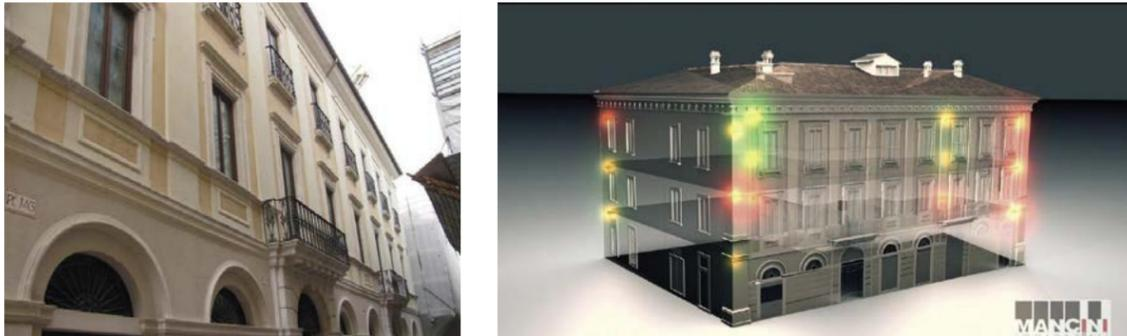
Figura 4. Palazzo Mannetti e schema di progetto installazione fibra ottica. Un progetto dell'ing. Diego Dell'Erba con la collaborazione della Sismlab, spin-off dell'Università della Calabria
