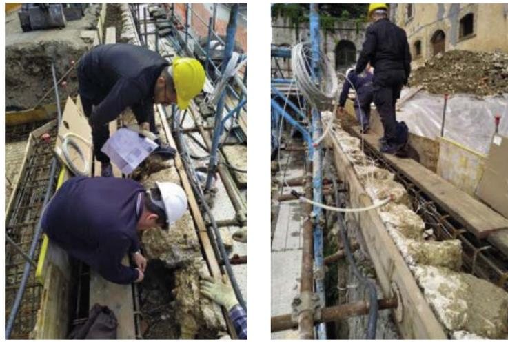
Figura 8. Ingegneri all'installazione dei sensori a fibre ottiche
