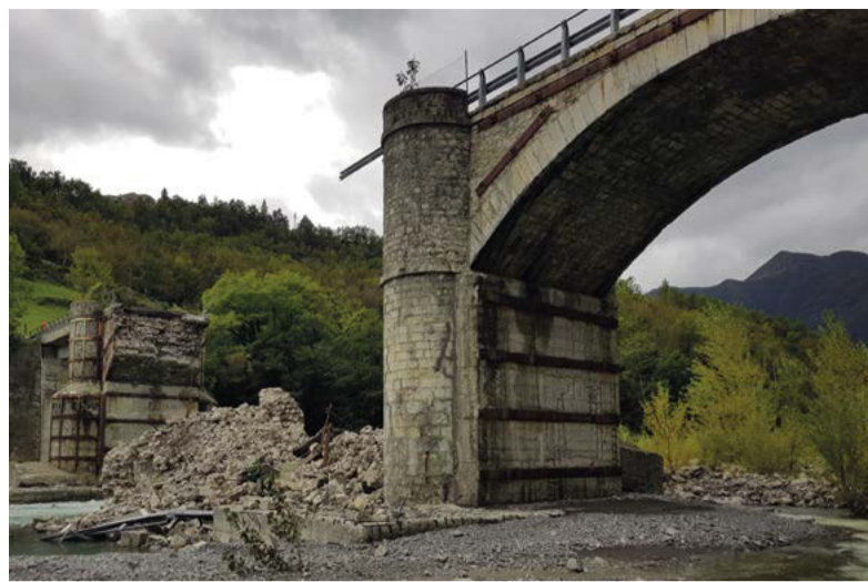
Figura 2. Fiume Trebbia, ponte della SS 45 a Corte Brugnatella (PC). Il ponte, soggetto negli anni a diversi interventi di rinforzo strutturale, è crollato nel 2020 a causa dell'erosione del fondo alveo in corrispondenza di una pila. (Foto degli autori)
