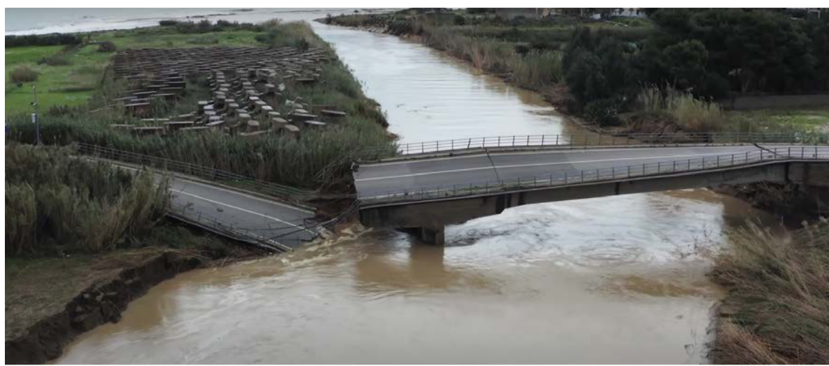
Figura 3. Fiume San Bartolomeo, ponte della SS 187 a Alcamo (TP). Un evento di piena del 2021 ha causato erosione della sponda, con conseguente cedimento della struttura. ( https://www.youtube.com/watch?v=PK3qk0pM7es )
