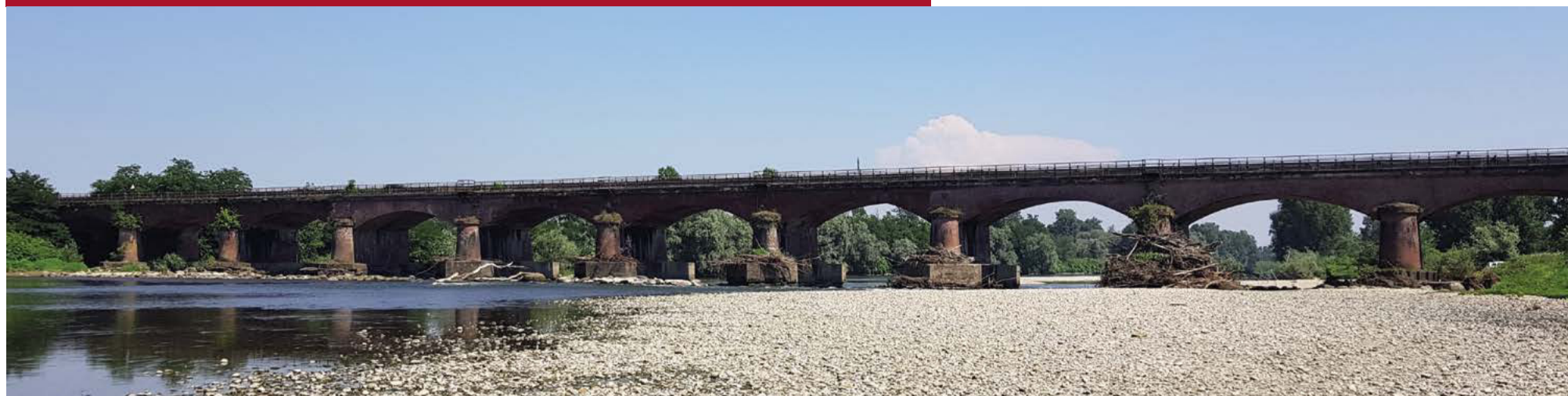
Figura 4. Fiume Sesia, ponte della SP 596 a Candia Lomellina (PV). L'alveo del fiume ha subito progressivo abbassamento negli anni, con conseguente esposizione delle fondazioni. Significativi accumuli di materiale vegetale. (Foto degli autori)
