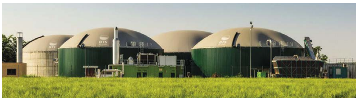
Figura 5. Impianto Biogas Soc. Agr. Ronconi in Marmirolo (MN) (fonte Prenn S.r.l.)
