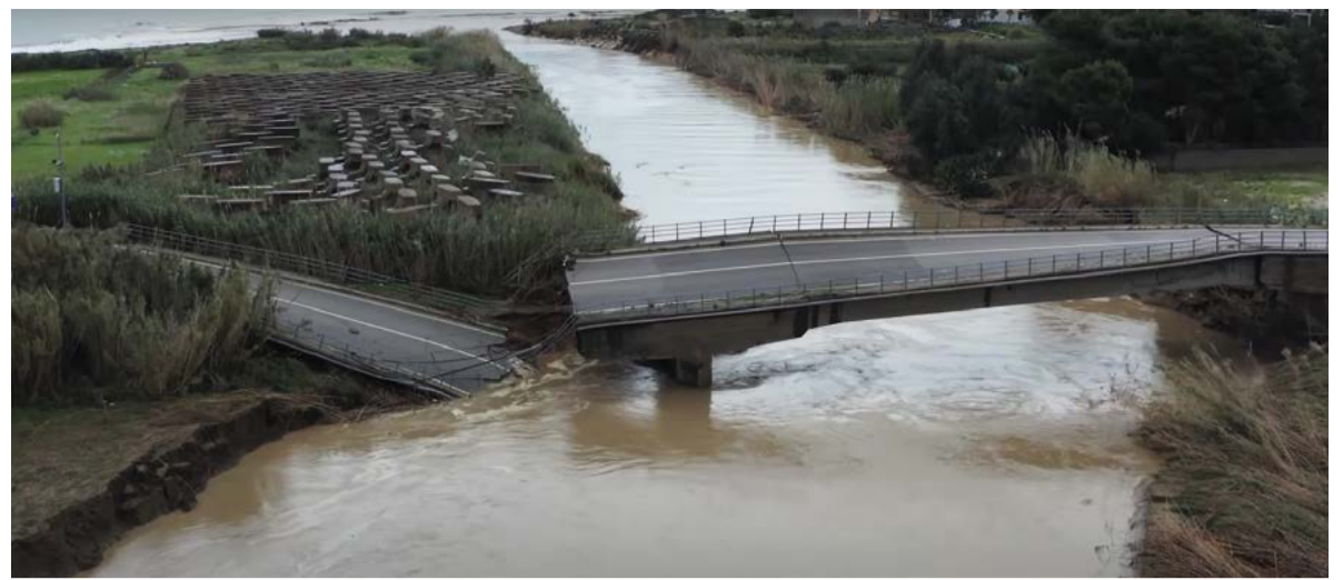
Figura 3. Fiume San Bartolomeo, ponte della SS 187 a Alcamo (TP). Un evento di piena del 2021 ha causato erosione della sponda, con conseguente cedimento della struttura. ( https://www.youtube.com/watch?v=PK3qkqM7es )
