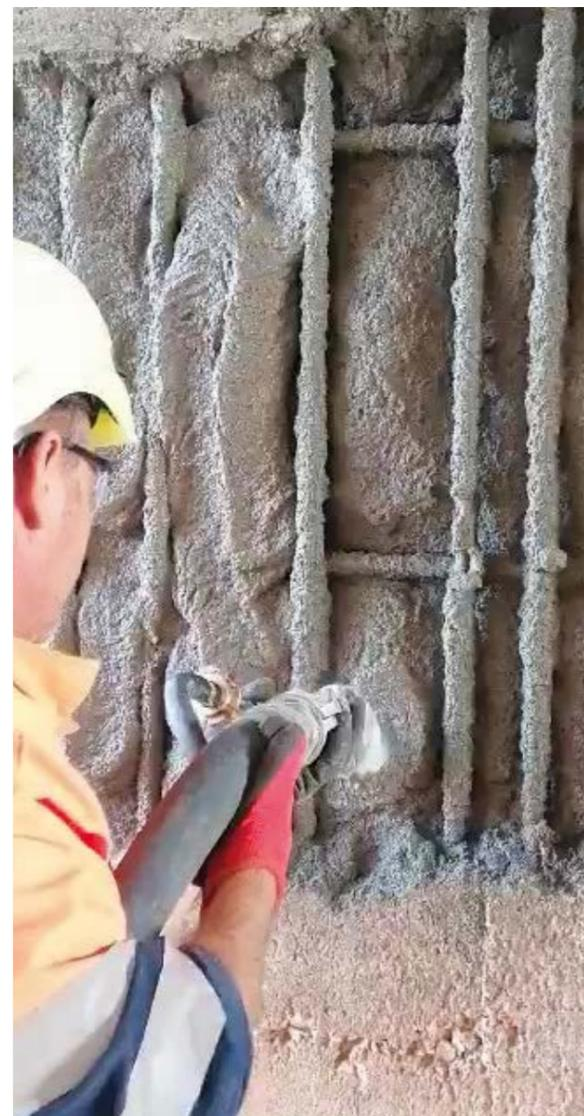
Sopra: intonaco strutturale ad alto spessore. A sinistra: pavimentazione della banchina al porto di Loano.
